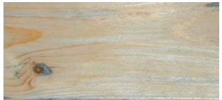
Herkömmliche farblose Lasur ohne UV-Schutz Folge: Irreparable Vergrauung/Bläueschäden
