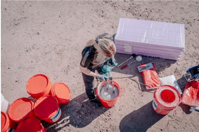
Der zweikomponentige reaktive Dämmplattenkleber MB Fix 2K ermöglicht die sichere, schnelle und wirtschaftliche Verklebung von Dämmplatten an Keller-Außenwänden.
