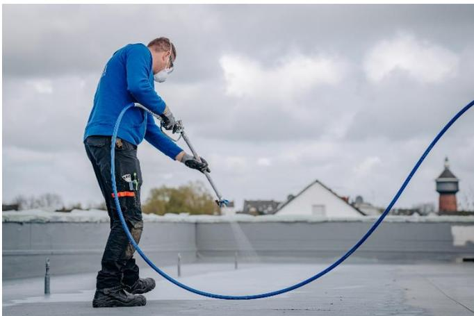
Durch die kalte Verarbeitung ohne Reaktionswärme bietet MB PUReactive+ höchste Sicherheit vor ungewollter Entzündung der Dachflächen.
