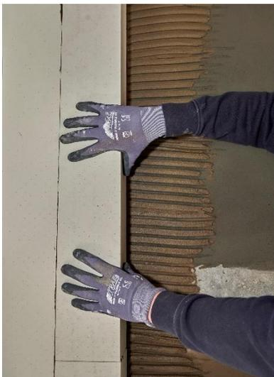
Die neue Streifentechnologie des iQ-Therm 2.0 Systems ist – senkrecht angebracht – ideal, um runde Wände passgenau zu dämmen.
