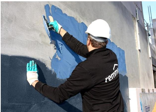
MB 1K rapid und MB 1K S erfüllen als 1K Flexible Polymermodifizierte Dickbeschichtung (FPD) alle Anforderungen an die schnelle und sichere Bauwerksabdichtung.
