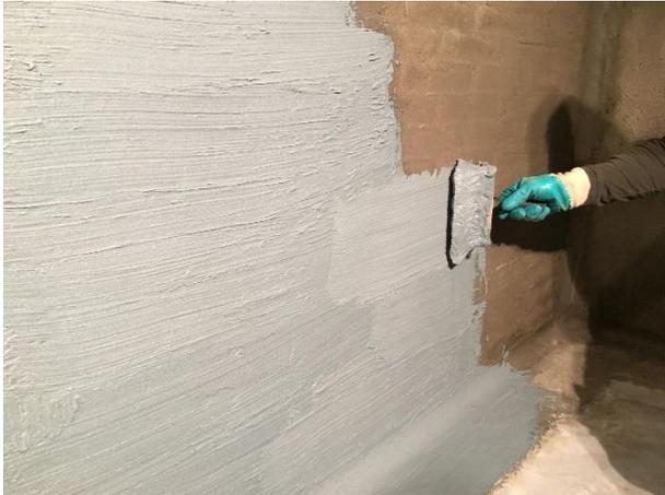
Verarbeitung des flex-Systems: Die erste Abdichtungslage aus MB 2K wird mittels Schlämmbürste auf die zuvor aufgetragene Egalisierungsschicht aufgebracht.
