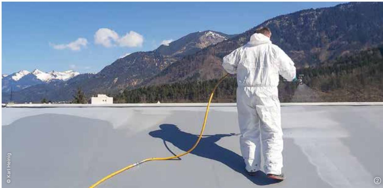
② Das Material bildet eine nahtlose und flexible Regenerationslage auf der PVC-Folienabdichtung, die gleichzeitig eine vollwertige Abdichtung darstellt.
