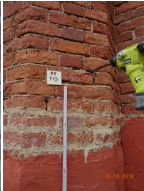
Фото 29: проба кладочного раствора P13
