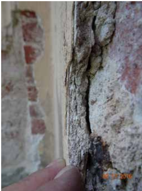
Фото 28: Повреждения штукатурки (рядом с осью A6)
