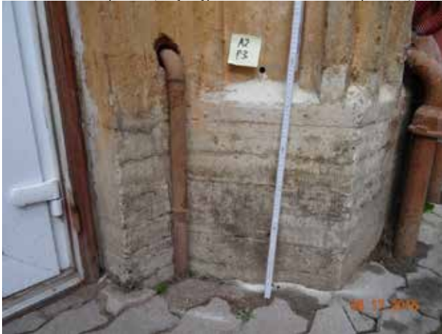
Фото 28: Повреждения штукатурки (рядом с осью A6)
