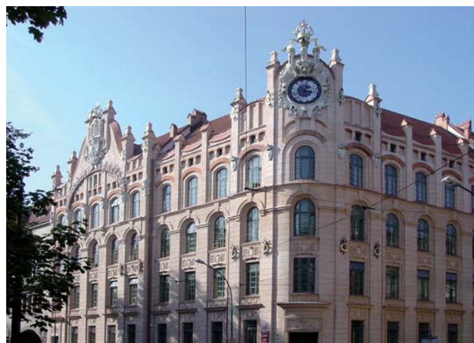
Handelsakademie, Krakau; Fassadenaufbau in Romanzementtechnologie
