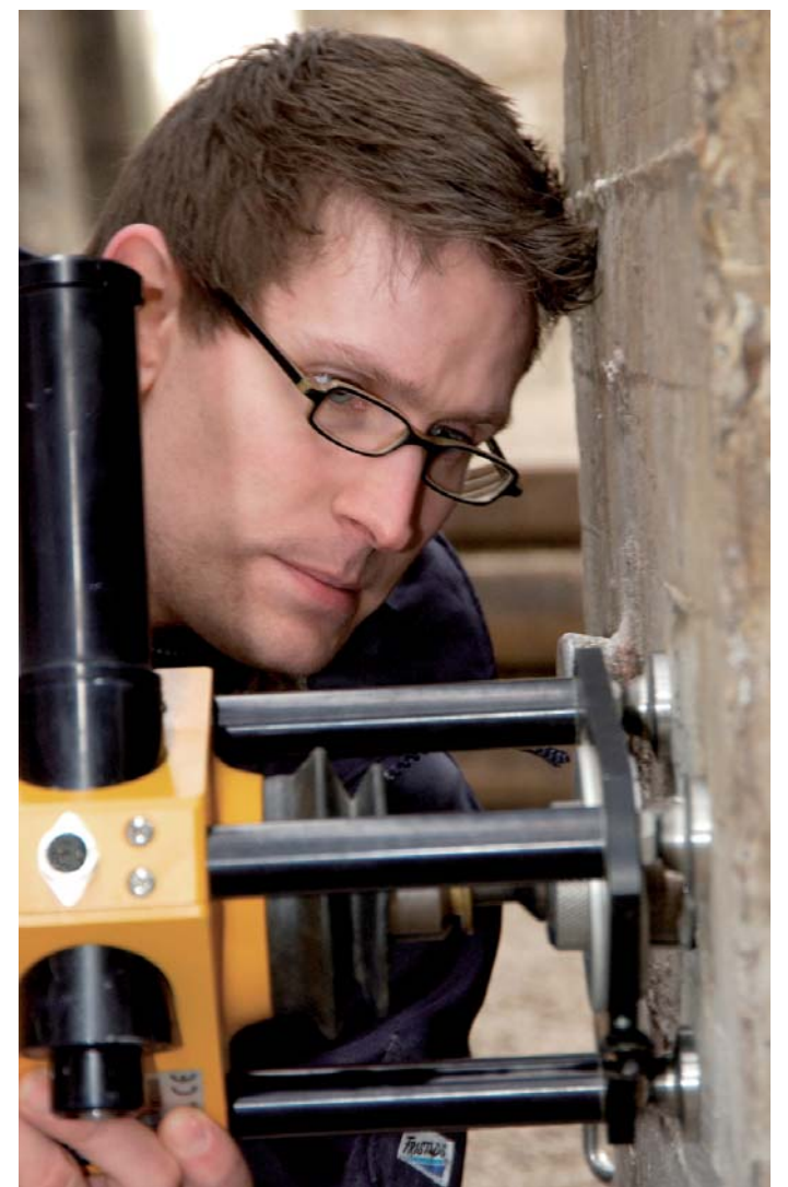
Ermittlung der Haftzugwerte des originalen Betons
