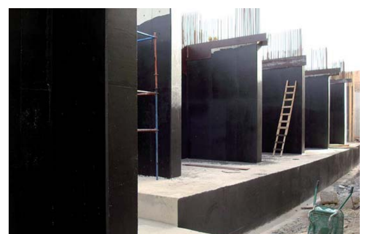
Die schnelle Durchtrocknung der Spritzabdichtung 2K stellt den optimalen Bauablauf sicher.
