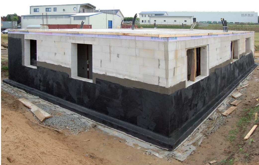
Fertig gestelltes Abdichtungssystem aus vertikaler bituminöser Bauwerksabdichtung in Kombination mit mineralischer Sockelabdichtung
