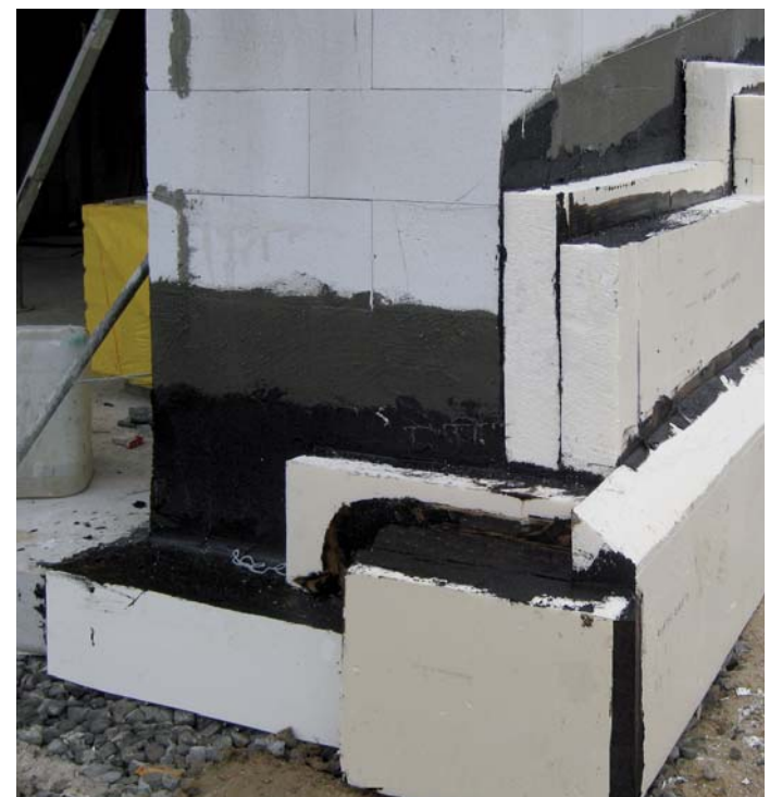
Schutz für die Bauwerksabdichtung und Wärmedämmung in einem Verbund wird nur durch die vollflächige Verklebung mit Profi Baudicht auf der durchgetrockneten Abdichtungsmatrix sichergestellt.
