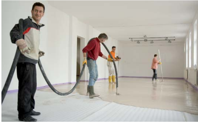
Einbau des Fließestrich
