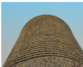
Bauzeitliche Mörtel am Mächtenturm, Baku / Aserbaidschan
