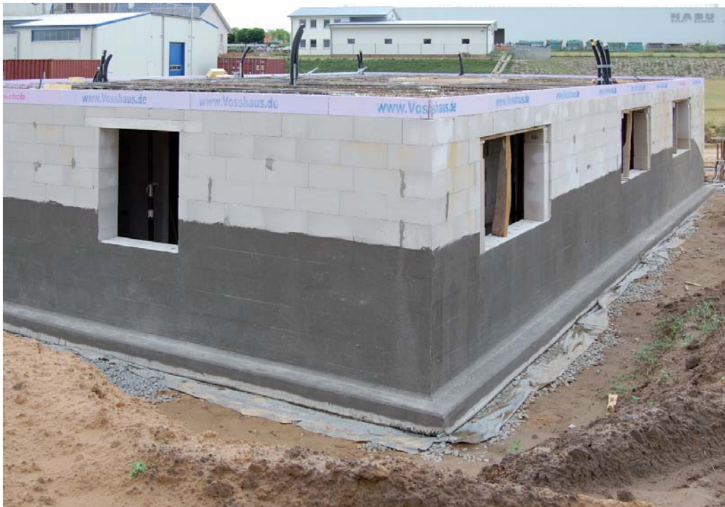
Vollflächiger Hinterfeuchtungsschutz als Bestandteil der RSG Abdichtung – mit der Dichtschlämme im Kiesel-System auch bei großen Flächen sehr wirtschaftlich ausführbar.
