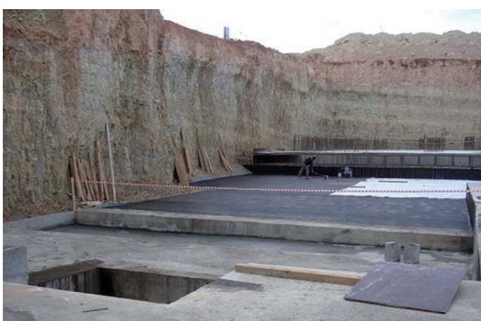
Die Abdichtung der Bodenplatte mit der Spritzabdichtung 2K stellt eine wichtige Grundlage der umfassenden Bauwerksabdichtung dar.
