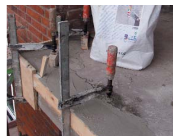
Nach- und anarbeiten von geschlossenen Kanten-Schadstellen an intakten Betonflächen.
