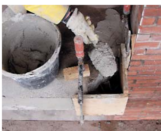
Einschalen der freigelegten und vorbereiteten Eck-Schadstellen und Schließung mit Betofix RM.
