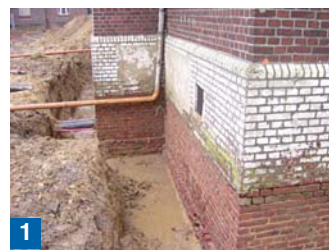
1 Mit Hochdruckreinigung vorbereiteter Untergrund.
