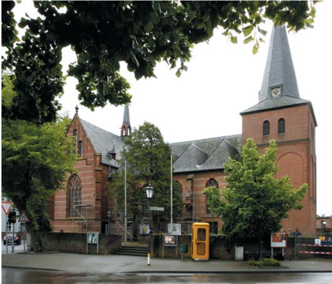
Die Kirche St. Michael in Eldorf-Berrendorf ist eine dreischiffige Hallenkirche mit Kreuzrippengewölben. Das Gewölbemauerwerk aus dem 16. Jahrhundert war einsturzgefährdet; jetzt wurde ein Instandsetzungskonzept von einem Expertenteam gefunden.
