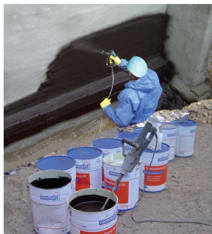
Komplette Abdichtung: Kiesol / Remmers Sulfatexschlämme in dreifacher Schlämmfolge, Remmers Dichtspachtel, bituminöse Remmers Spritzabdichtung 2K, Dämmplattenkleber, Perimeterdämmung und Remmers DS Systemschutz.
