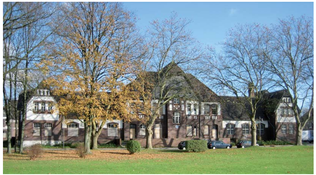
Instandsetzungsobjekt: ehem. Kantine und Verwaltungsgebäude der britischen Rheinarmee
