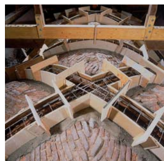
Die saubere Verschalung der Überzüge oberhalb der Gewölberippen erforderte herausragendes handwerkliches Geschick.
