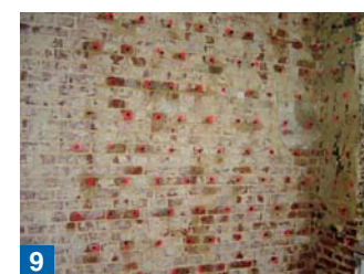
9 Schwammbefallene Wand mit Packern für normgerechte Verpressung von Adolit M flüssig.
