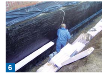
6 Kleben der Perimeterdämmung nach DIN 4095 aus extrudiertem Polystyrol-Hartschaum.
