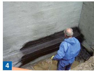
4 Auftrag der bituminösen Remmers Spritzabdichtung 2K.
