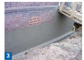
3 Sulfatbeständige, mineralische Abdichtung durch Grundvergieselung mit Kiesol und Remmers Sulfatexschlämme bis OK Erdreich.
