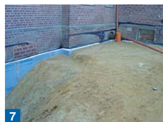
7 Verfüllte Baugrube nach Anbringen des Drän- und Anfüllschutzes DS-Systemschutz.
