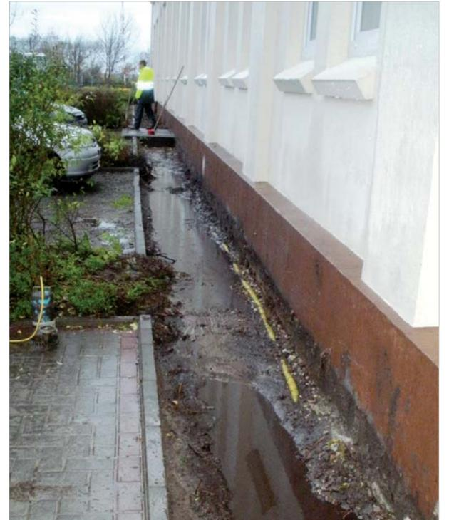
Freigelegter Sockel vor der Sanierung – erkennbar der hohe Grundwasserstand
