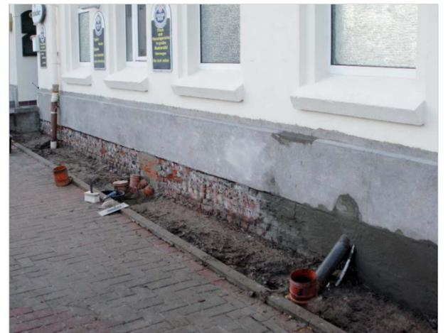
Horizontalsperre durch Bohrlochinjektage mit Kiesol
