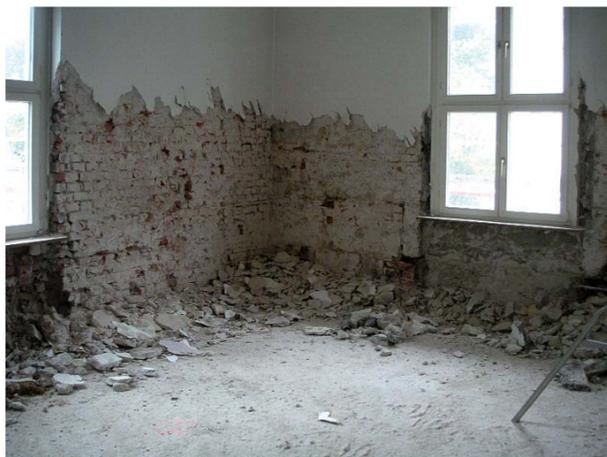
Der Feuchte ziehende, alte Gipsputz an den Innenwänden der Außenmauern in der Dicke von 30 bis 100 mm musste durch einen Sanier- bzw. Kalkzementputz ersetzt werden.
