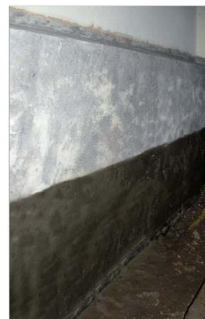
Salzresistente Haftbrücke mit Sulfatexschlämme schnell
