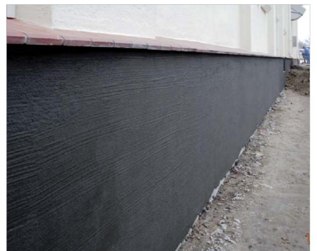
Abgedichteter Sockel mit Multi-Baudicht 2K
