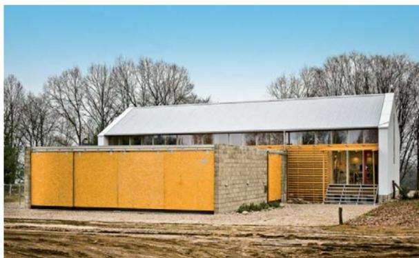
So, oder so ähnlich, sieht das Haus der Zukunft aus. Daran werden wir uns gewöhnen müssen. Die Vorteile sind einfach zu überzeugend. 3,6 kW reichen aus, die Räume in dem 288 m<sup>2</sup> großen Passivhaus bei Bedarf aufzuheizen. Da reichen drei kleine Heizlüfter aus dem Baumarkt, denn der Energieeinsatz konnte mit dieser Bauweise um 90% reduziert werden.
