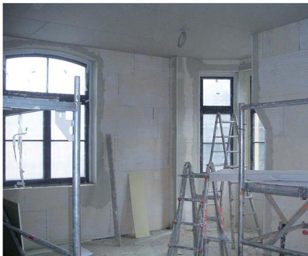
600 m<sup>2</sup> Wandflächen erhielten eine Innendämmung mit iQ-Therm 50
