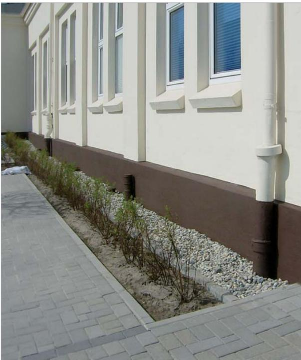
Abdichtung mit dem UV-stabilen Multi-Baudicht 2K, durchgehend von der erdberührten Sockelunterkante bis 1 m oberhalb Gelände (Aufnahme nach dem Schlußanstrich mit Betonacryl).
