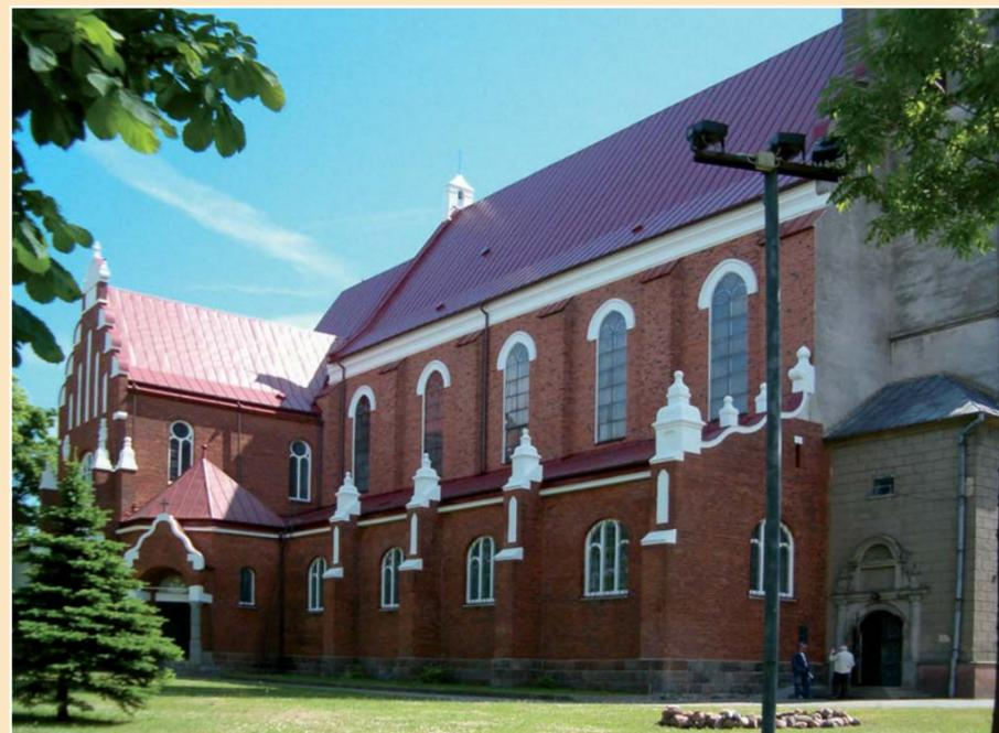
Freilegung der historischen Sichtmauerwerkfassade in der 2. Etage, hydrophobierende Imprägnierung und Ziegelrestaurierung im Funcosil-System. Instandsetzung der Putzbereiche im Remmers Siliconharz-Farbsystem LA, bereichsweise Neuverputz mit Salzspeicherputz.
