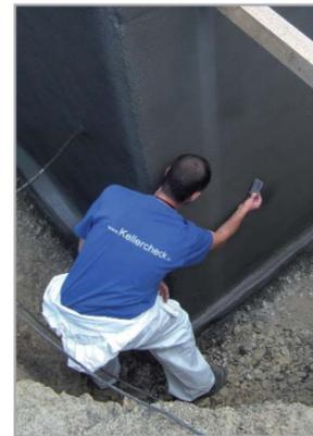
Messung der Frischschichtdicke von Multi-Baudicht 2K
