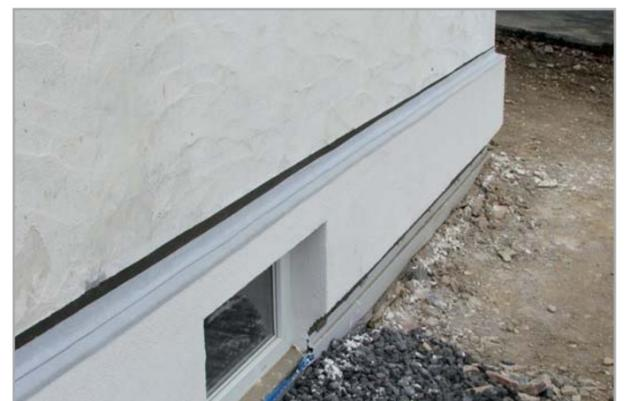
Fertige Ausführung des gedämmten Sockelbereiches mit Sockelschiene für das Dämmsystem im Wandbereich.
