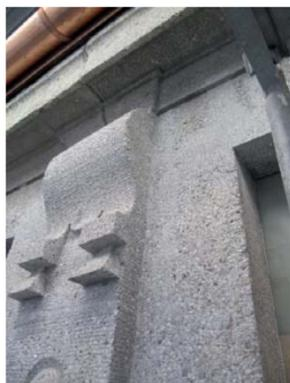
Abgeschlossene Schadstellenreparaturen und Reprofilierung mit Betofix RM
