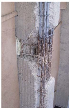
Freigelegte, korrodierte Bewehrungsseisen eines Pilasters bis auf eine Tiefe von ca. 20 mm hinter dem Eisen.
