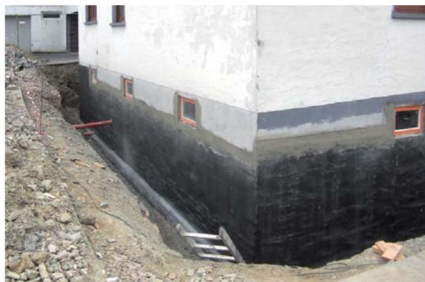
Untergrundvorbehandlung durch Auftrag von Dichtspachtel und einer Kratzspachtelung mit Multi-Baudicht 2K
