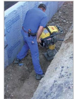
Dreilagige Drainschutzbahn mit Systemkomponenten; lagenweises Anfüllen und Verdichten
