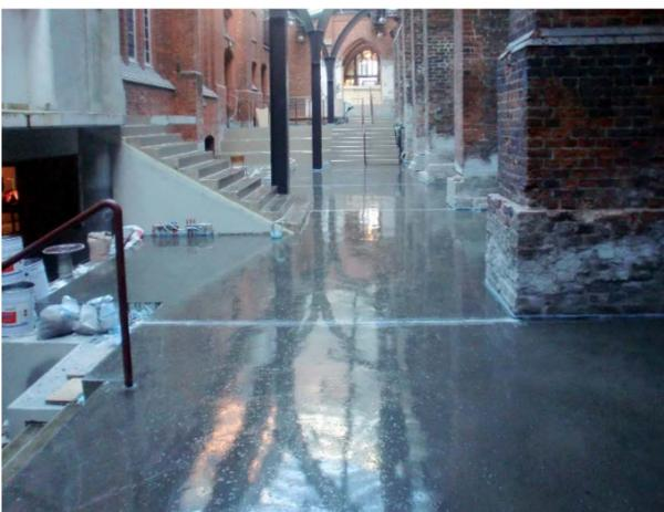
Abb. 3: Grundierung und Egalisierungspachtelung wurden bereits ausgeführt.
