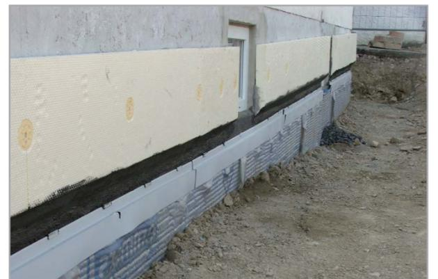
Fassadensockel mit Anschluss zwischen Abdichtung und Wärmedämmung
