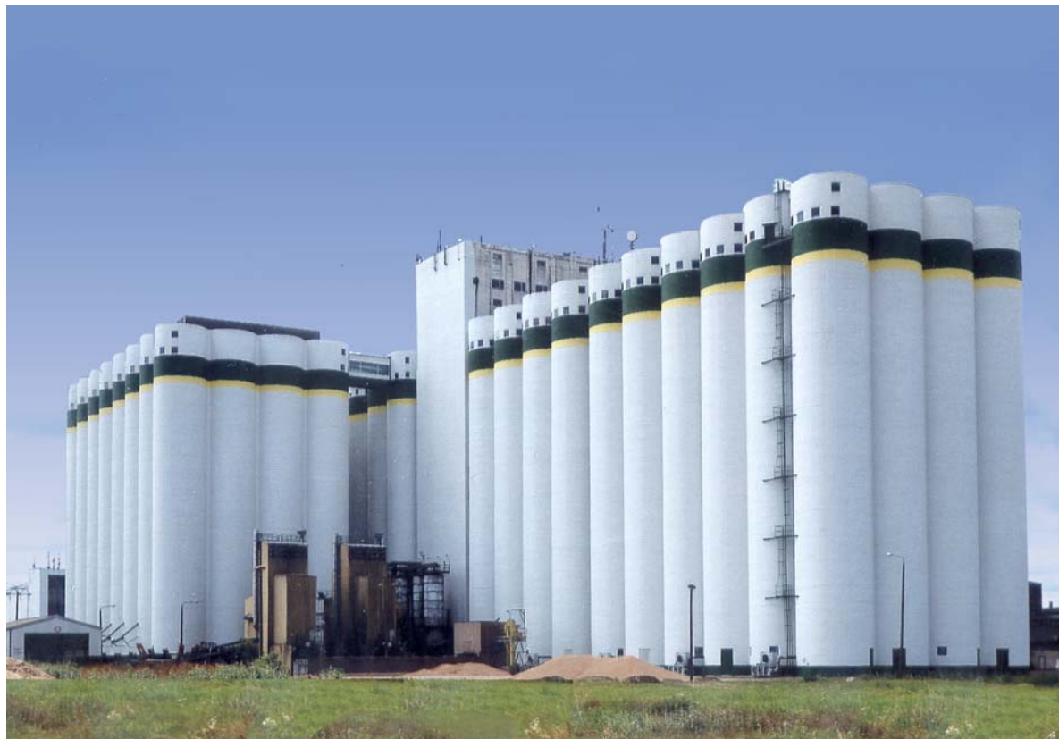
Europas größter Rundzellen-Getreidesilo in Karstädt nach der Sanierung
