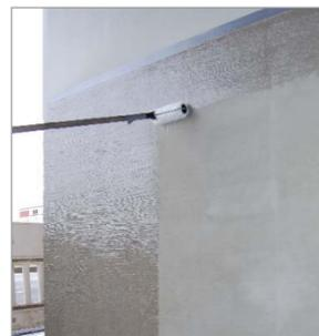
Grundierung der senkrechten Bauteile mit Epoxy ST 100.
