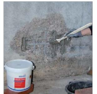
Aufbringen von Korrosionsschutz und Haftbrücke mit Betofix KHB (Instandsetzungsprinzip C).
