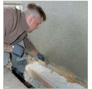
Herstellung einer Hohl- und Dreieckskehle an allen innenliegenden Kanten.
