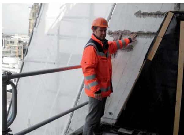
Diplom-Restaurator Lindlar: zu geringe Betonabdeckung - Bewehrungsstahl korrodiert infolge Carbonatisierung.
