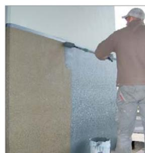
Auftrag Deckversiegelungsschicht mit Remmers Epoxy Color.
