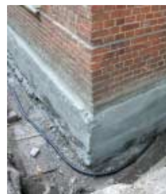
Mineralisch abdichtende Egalisierung zur Aufnahme der kunststoffmodifizierten Bitumen-Dickbeschichtung.
