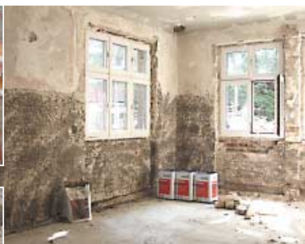
Die Bodenplatte im Erdgeschoss wurde erneuert. Aufbau: 100 mm Wärmedämmung, WLG 035, Folie, Betonplatte mit Schweißbahn und Dämmung mit Fußboden-Heizung. Beschichtung je nach Nutzung mit Fliesen bzw. Linoleum.
