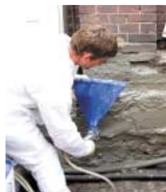
Stufe 1 und 2 der vertikalen Bauwerksabdichtung: Grundverkiegelung und Tiefschutz im Porengefüge mit Kiesel; Auftrag von Sulfatexschlämme und Dichtspachtel zum Schließen von Fehlstellen und offenen Fugen.
