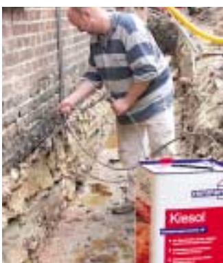
Kiesel ist hervorragend als Injektion gegen kapillare Feuchte geeignet, um bei hohen kapillaren Durchfeuchtungsgeraden im Niederdruckverfahren kontrolliert das Mauerwerk zu durchtränken.
