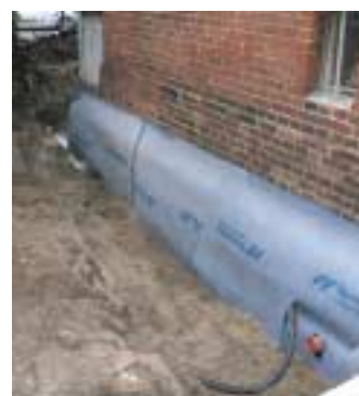
Der DS-Systemschutz verhindert durch die eingebaute Gleitschicht die Übertragung von Scherkräften auf die Abdichtungsebene.
