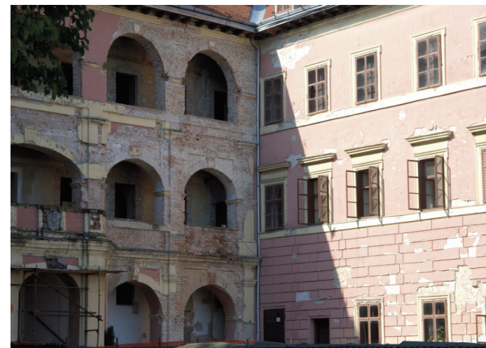
Hofseite vor der Instandsetzung – Übergang der Römischen Fassade zur geputzten Fassade
