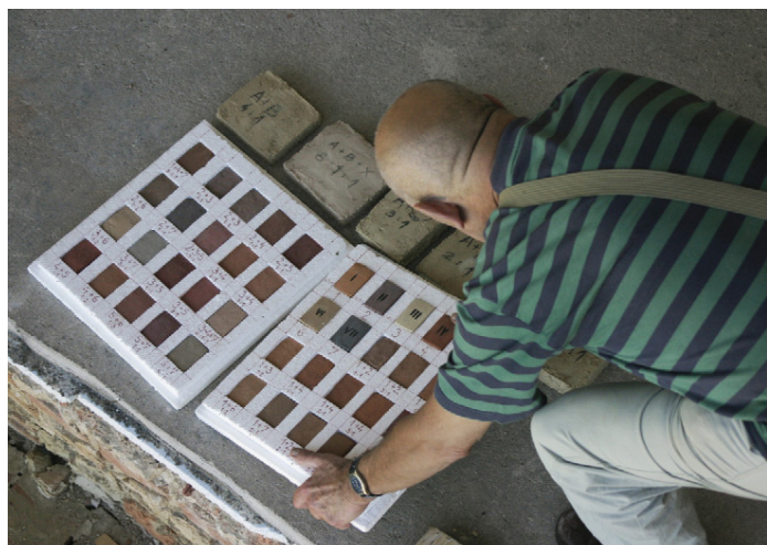
Kunsthistoriker Vladimir Markovic bei der Farbtonbestimmung für Ziegelrestaurierung und Neuverfugung der Römischen Fassade.
