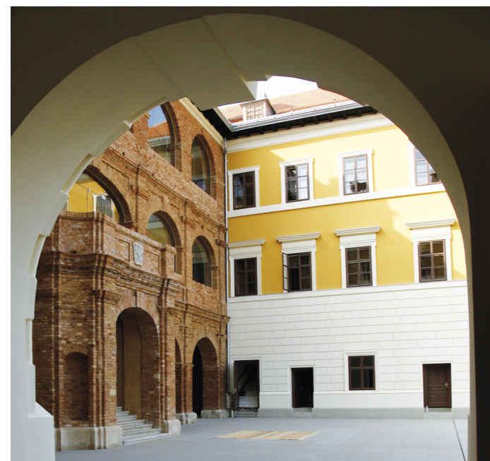
Ansicht der Hofseite nach der Instandsetzung – Übergang der Römischen Fassade zur geputzten Fassade
