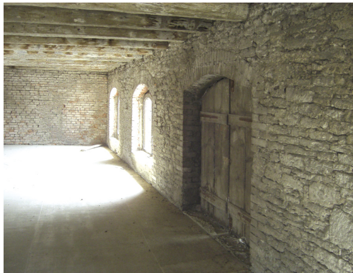
Der entkernte Speicher
