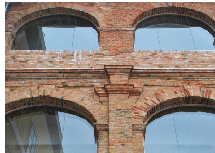
Die Römische Fassade nach der Instandsetzung in einer Frostperiode. Die Eiszapfen an der Fassade demonstrieren den Erfolg der Sanierung: die zerstörerische Wasseraufnahme findet nicht mehr statt.
