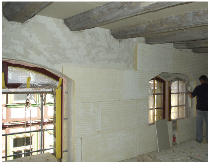
Einbau der iQ-Therm Innendämmung
