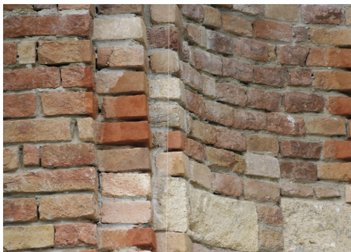
Mit Restauriermörtel SK restaurierte Ziegel an der Römischen Fassade
