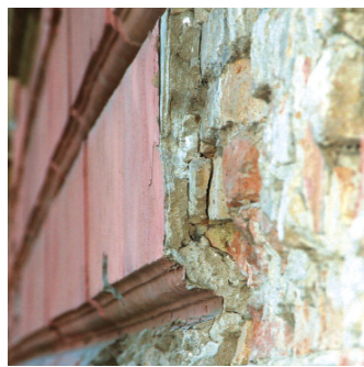
Ablösen des Quaderputzes
