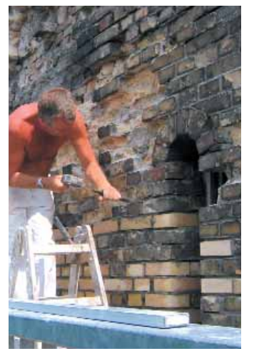
Ersatz defekter Klinker
