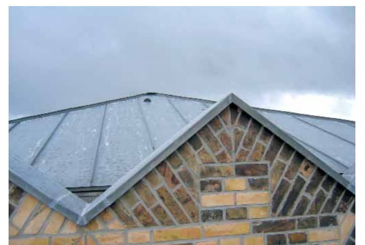
Das neuverfugte und mit Funcosil SNL imprägnierte Zinnenmauerwerk
