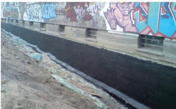
Zweilagige Abdichtung mit der kunststoffmodifizierten Bitumenabdichtung Profi Baudicht 2K bis Oberkante Erdrreich. Hochdruckfest durch die Füllstofftechnologie mit Gummigranulat.
