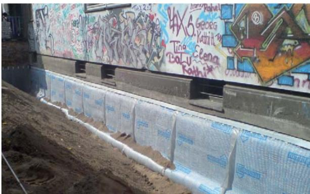
Schutz der vertikalen Abdichtung mit DS-Systemschutz und der DS Abschlussleiste.
