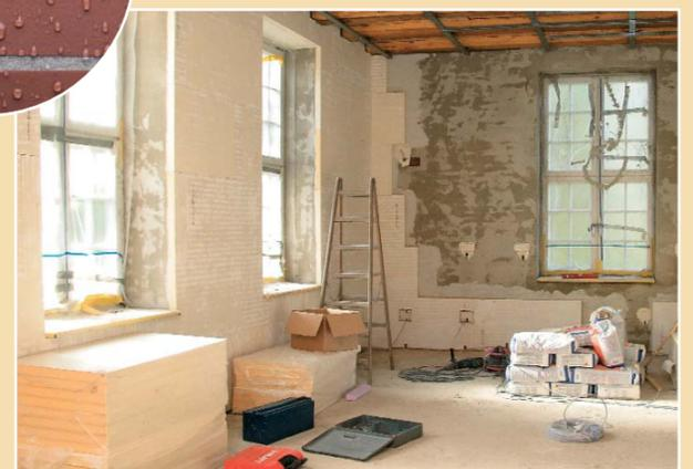
Das rote Backsteingebäude mit seiner ursprünglichen Fassadengliederung und den Gesimsen bildet ein Ensemble mit den beiden Villen Mühlentor 4 und 5. Die Optik dieser architektonischen Einheit sollte unbedingt erhalten bleiben. Deshalb kam für die energetische Gebäudeinstandsetzung der Villa nur der Einsatz des iQ-Therm-Innendämm-Systems in Betracht.
