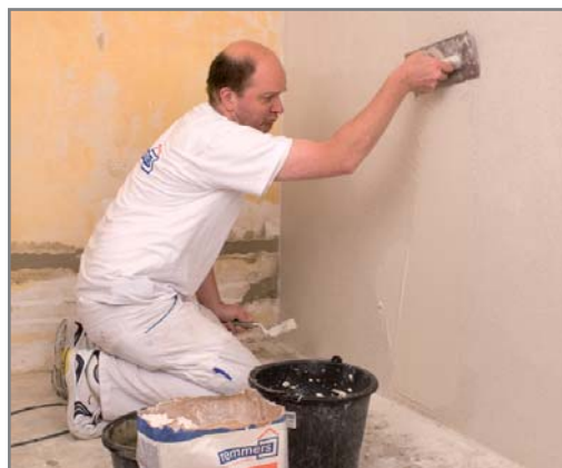
Den angemischten Spachtel iQ-Fill mit der Traufel aufziehen und die Putzfläche abziehen bzw. glätten.
