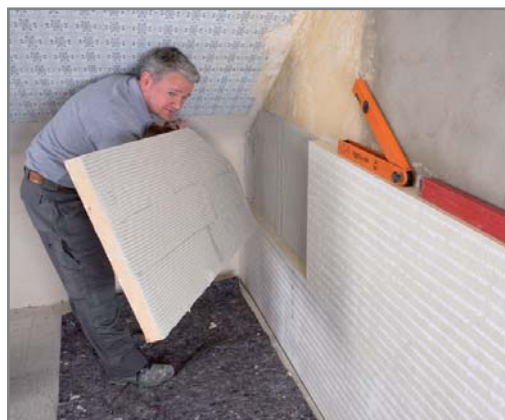
Die iQ-Therm-Platte wird in das frische Klebbett eingedrückt und ausgerichtet. Kreuzfugen müssen vermieden werden, an Öffnungen die Platten ausklinken!
