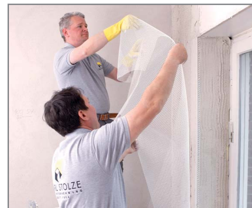
Das Armierungsgewebe iQ-Tex wird mit dem Glätter in senkrechten Bahnen faltenfrei in den Mörtel eingearbeitet.
