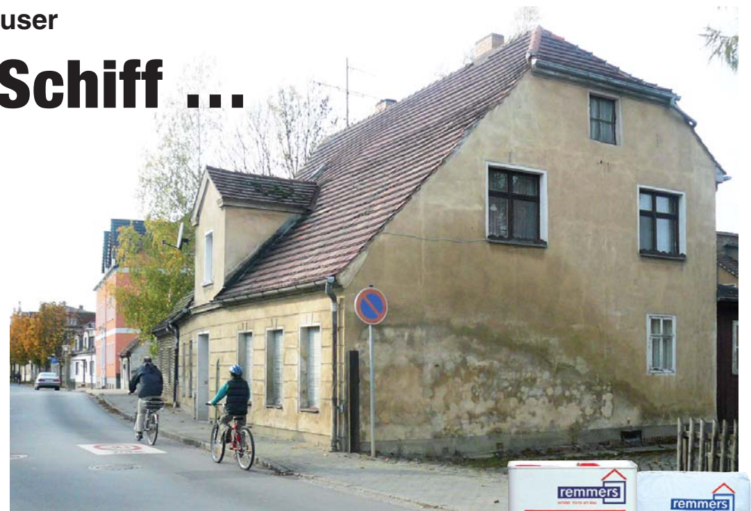
Der Wunsch des Bauherren: Freilegung des alten Klinkermauerwerks und Sandstrahlung, um es steinsichtig im Kontrast zu der neu verputzten Wand zu belassen.
