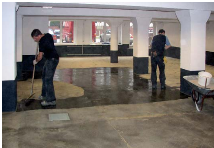
Grundierung des Bodens mit Epoxy ST 100 und nachfolgende leichte Abstreumung mit Quarzsand 01/03.
