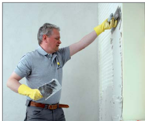
Der Putz iQ-Top wird als Armierungs- und Oberputz mit einer Schichtdicke von 5 Millimetern aufgezogen und durchgekämmt.
