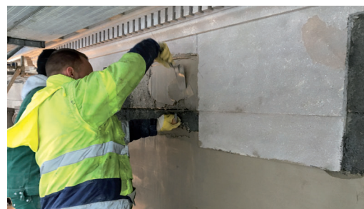
Auftrag Remmers Restauriermörtel an der Sandsteinfassade.
