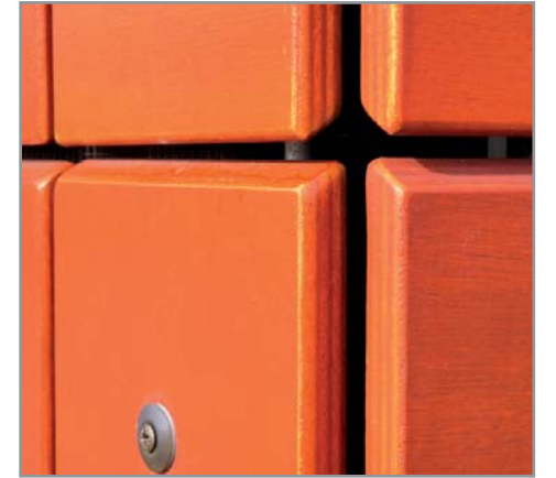
Abgeschrägte Kanten für den Wasserablauf
