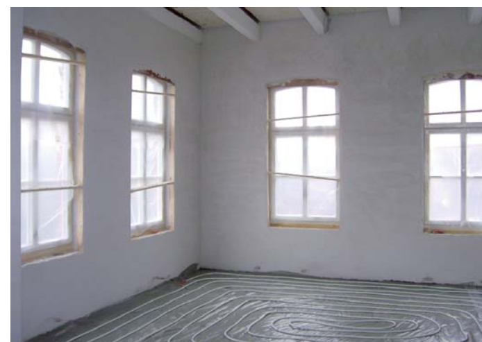
Raumansicht vor Einbau der Fensterlaibungsplatten und Abglättung der Putzflächen mit dem Spachtel iQ-Fill.
