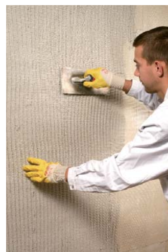
Das Armierungsgewebe iQ-Text wird faltenfrei eingearbeitet.
