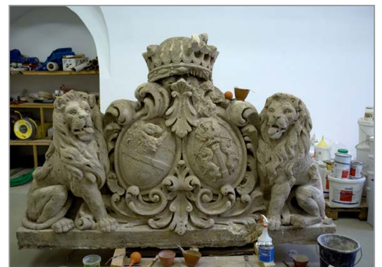
Exzellente Ergebnisse der konservatorisch-restauratorischen Arbeiten in den Werkstätten der kroatischen Behörde. Eingesetzt wurden u.a. Glaspudermehl 0,04-0,09 mm, Restauriermörtel, Funcosil FC und Historic Schlämmlasur.
