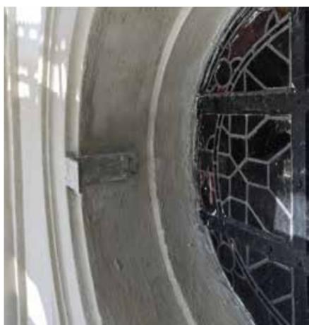
Nach Entfernung des Altputzes erfolgt die Bearbeitung der Fenstereinfassungen mit dem mineralischen Steinerfüllmörtel Betofix RM pro.
