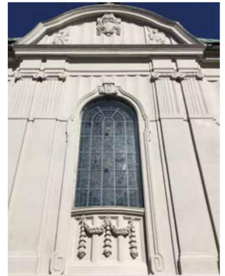
Im Zuge umfangreicher Sanierungsarbeiten wurde die denkmalgeschützte Betonfassade des Emslanddoms fachgerecht instandgesetzt.
