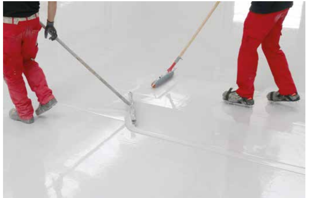
Fachgerechte Arbeit: Die Verarbeiter tragen das Beschichtungssystem von Remmers auf.
