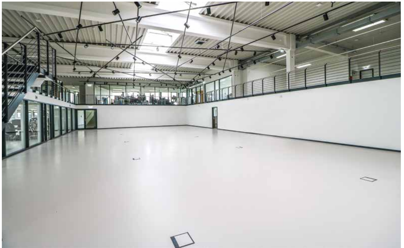
Der Lichthof im neuen Design-Center der Rabe Fashion Group mit einer Bodenschichtung von Remmers.
