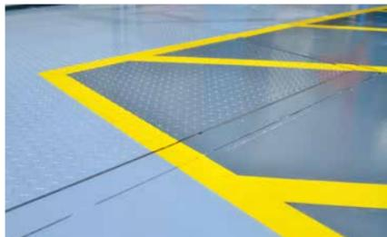
Bei der Beschichtung des Bodens kamen die Beschichtungsprodukte Epoxy BS 2000 und Epoxy BS 3000 von Remmers zum Einsatz.
