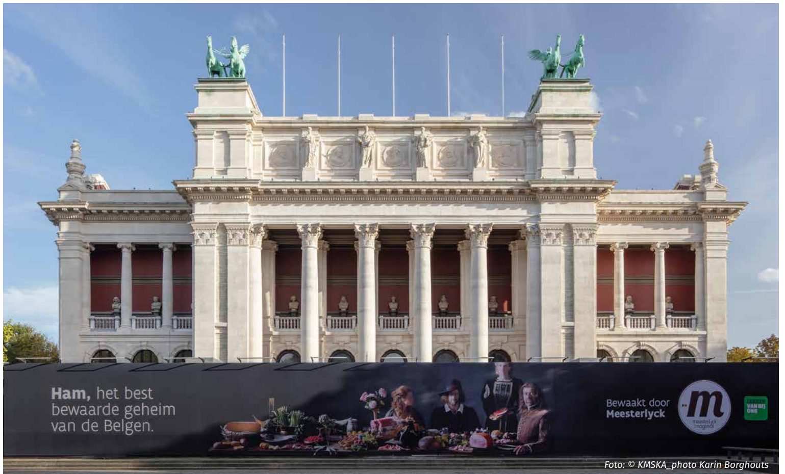
Die Natursteinfassade mit architektonisch einzigartigen Friesen, Büsten, Medaillons und Skulpturen aus der Kunstgeschichte wurde umfassend gereinigt.
