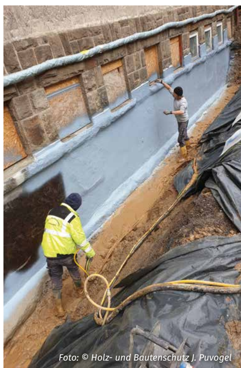
Nach ausreichender Trocknung spritzten die Verarbeiter Multi-Baudicht 2K in zwei Lagen mit Gewebeeinlage auf.
