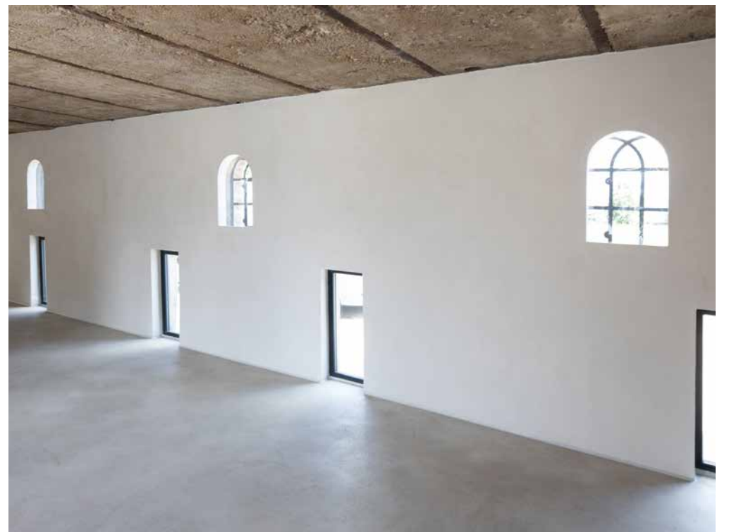
Der Innenraum nach der Sanierung.
