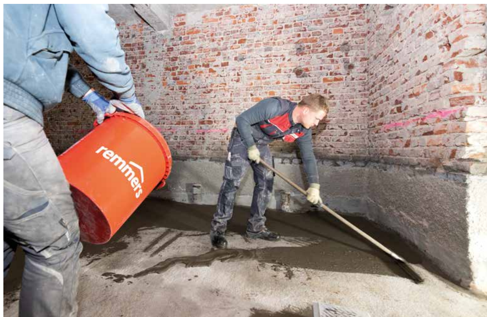
Zur Sanierung des Kellerbodens wurde die mineralische Dichtschlämme WP Sulfatex aufgebracht.
