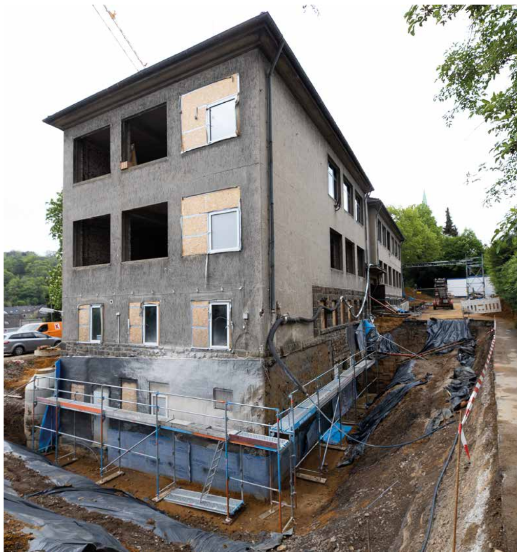
Für die Sanierung der Sockelfußpunkte der Dilldorfschule in Essen mussten die gesamten Außenwände – hier eine Teilfreilegung – zunächst bis auf 3,50 Meter Tiefe frei gelegt werden.
