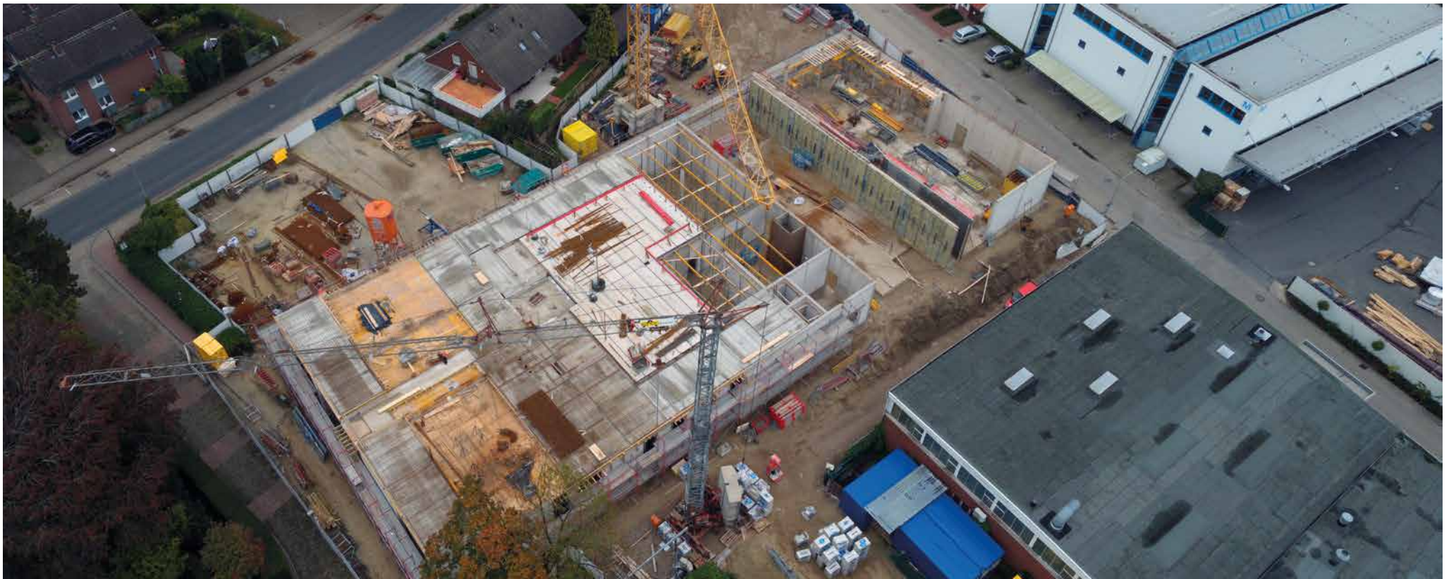
Das Kompetenzzentrum Bauten- und Bodenschutz befindet sich bereits im Rohbau.
