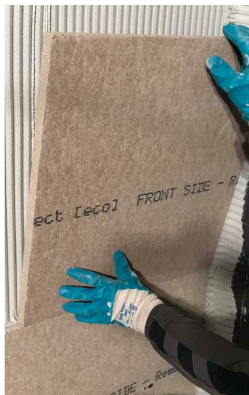
Als Schutz vor Schimmel wurden die Dämmplatten Power Protect P 25 / P 40 [eco] auf die Wand geklebt.
