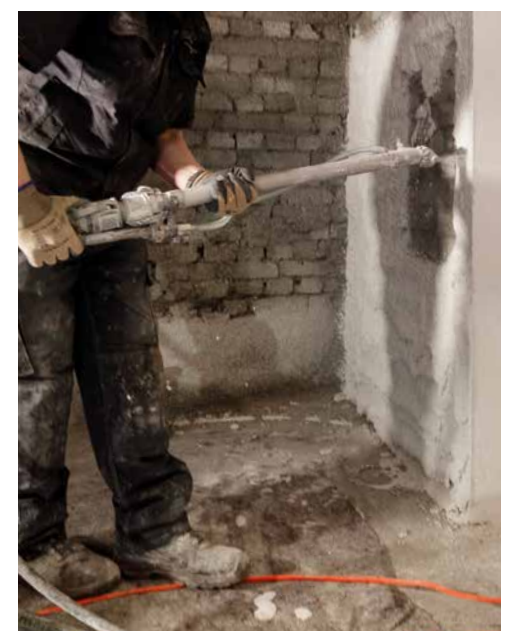
Auf den vorbehandelten Untergrund wurde der Sanierputz SP Top White aufgebracht.
