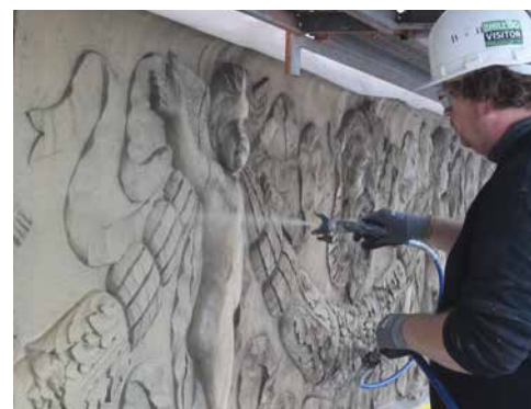
Schonender Auftrag von Clean Galena im Spritzverfahren auf die verschmutzte Fassade.
