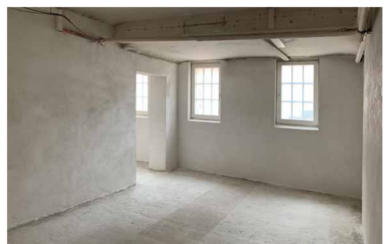
Auf den vorbehandelten Untergrund wurde der Sanierputz SP Top White aufgebracht.
