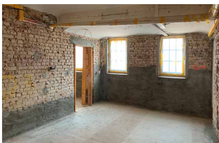
Blick in die Kellerräume: vor Beginn der Arbeiten (l.) und nach Abschluss der Sanierung.
