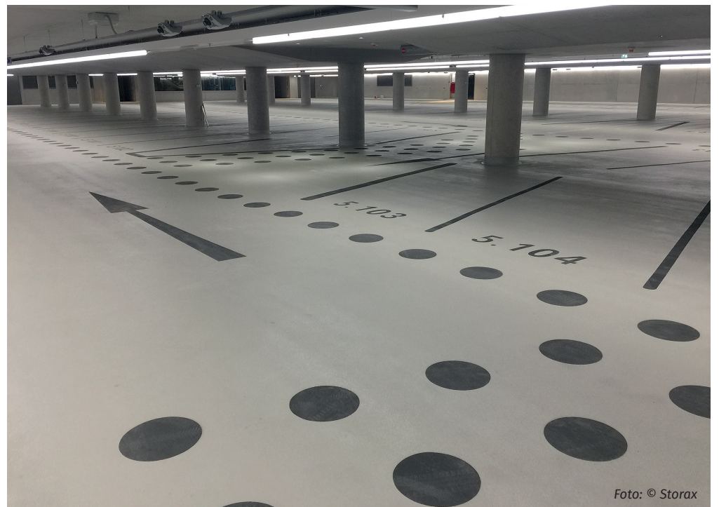
Die großzügig gestaltete Tiefgarage bietet auf fünf Parkebenen höchsten Nutzerkomfort.
