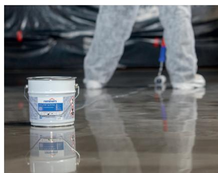
Als Versiegelung wird zum Abschluss Remmers PUR TOP M Plus aufgetragen.
