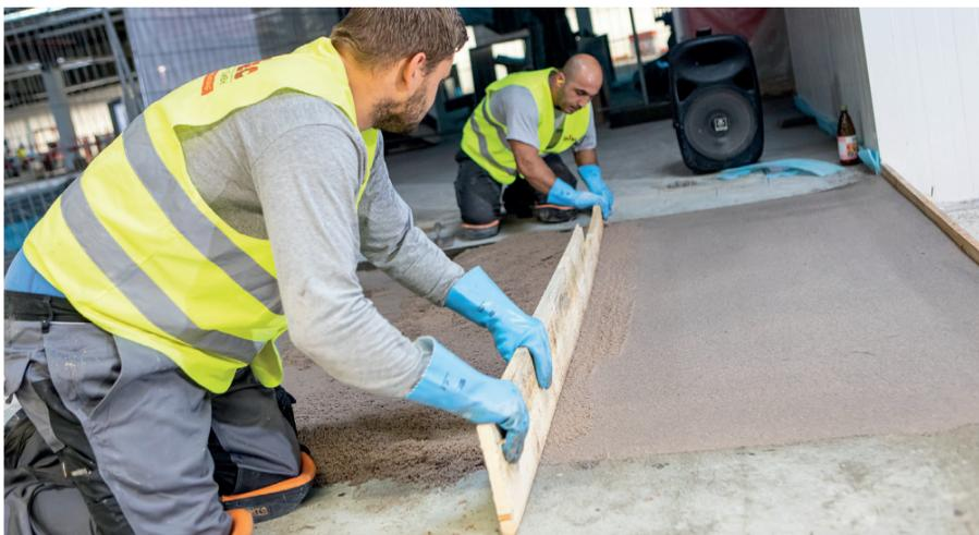
Hohl- und Schadstellen werden mit dem Betofix-System ausgebessert. Anschließend wird der Boden kugelgestrahlt.
