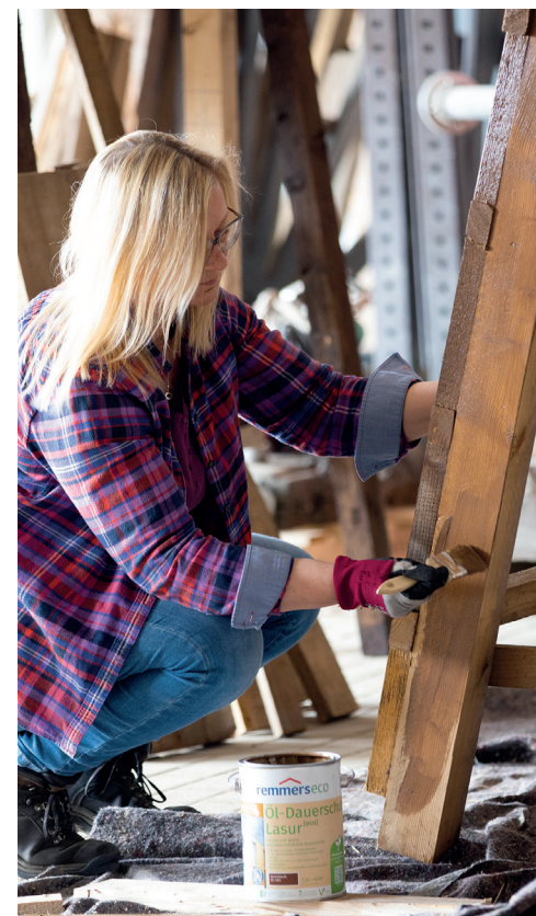
Im Anschluss an die Grundierung wurde die Öl-Dauerschutz-Lasur [eco] auf das Holz aufgebracht.
