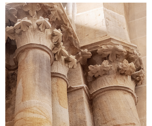
Die Peel-Off-Paste hat gegenüber einem Hochdruck-Verfahren den Vorteil, dass auch unebene Flächen optimal gereinigt werden können, ohne dass es zu Materialabtrag kommt.
