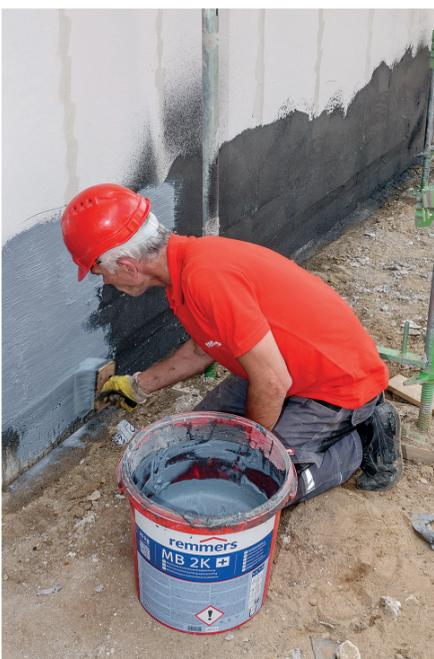
Zum Schutz der erdberührten Bereiche der Fassade wurde die multifunktionale Bauwerksabdichtung MB 2K von Remmers auf den Gebäudesockel aufgebracht.
