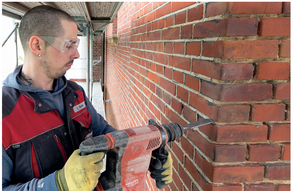
Die teils stark ausgebrochene Altverfugung wurde vorsichtig mit einem speziellen Flachmeißel entfernt.
