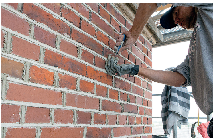
Für die originalgetreue Neuverfugung mischten die Verarbeiter zwei verschiedene Farbtöne des Trass-Kalk-Zement Fugenmörtels FM TK.
