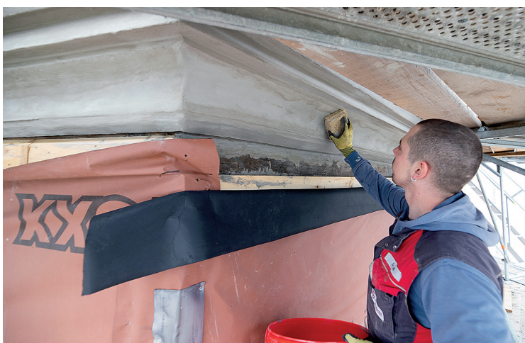
Die Gesimse am Turm wurden mit dem Betofix-System fachgerecht reprofiliert.
