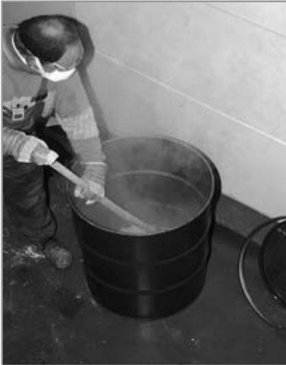
Abb. 2: Herstellung von „Kalkspatzenmörtel“ um das Jahr 2004 im Betrieb der Remmers Baustofftechnik GmbH, Lönigen
