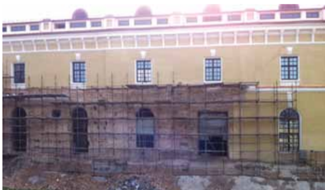
Nowy tynk w miejsce zmurowanych tynków
