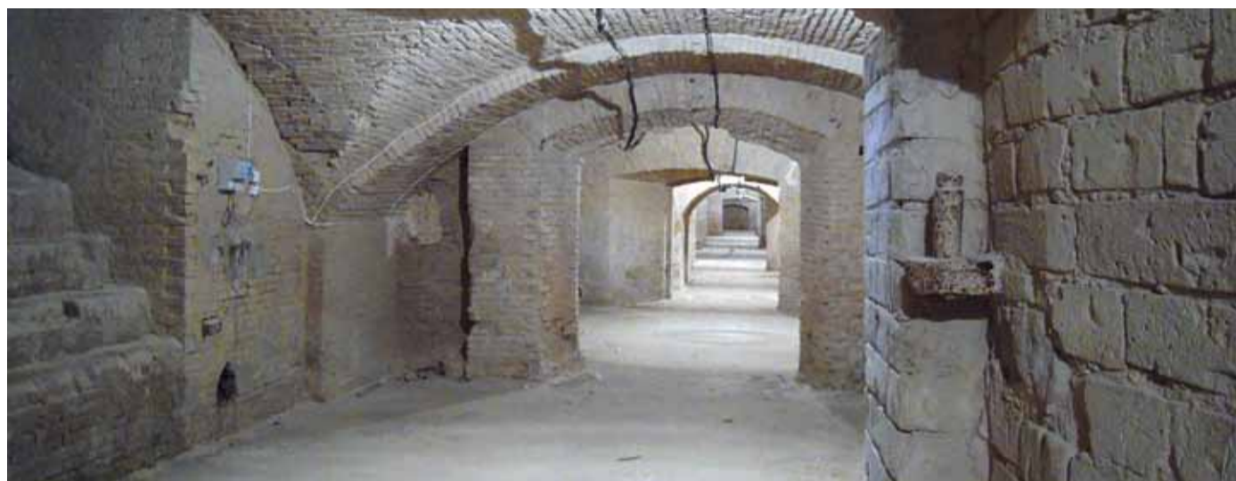
Widok obszernego sklepienia piwnicznego
