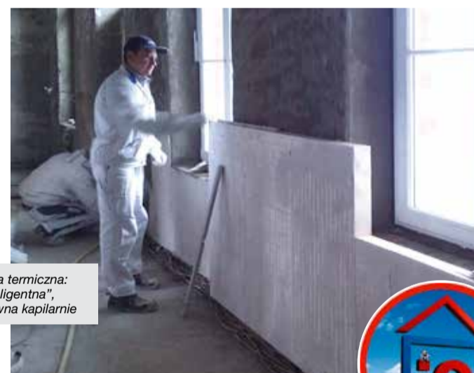
Montaż termoizolacji wewnętrznej z płyt iQ-Therm 80
