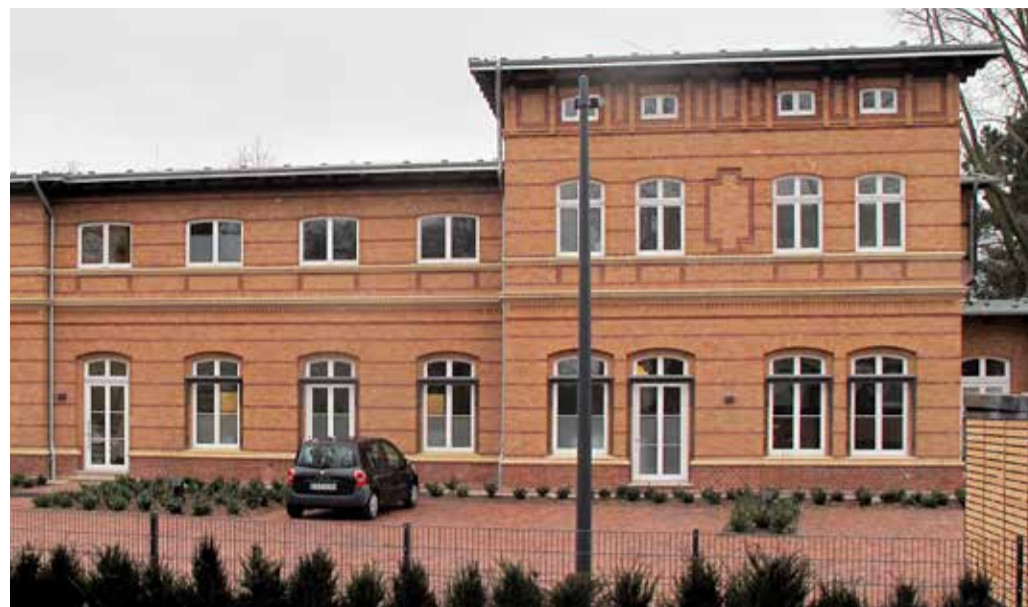
Po zakończeniu renowacji elewacji współczynnik nasiąkliwości mierzony rurką Kartsena wyniósł 0,0.
