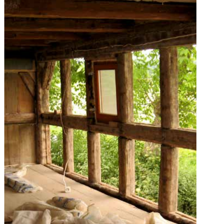
Konstrukcja przygotowana do wypełnienia
