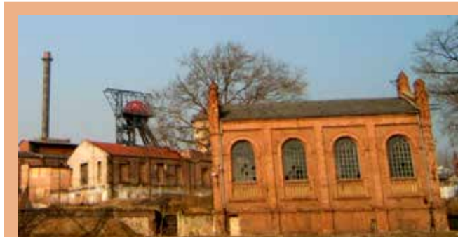
Kopalnia Katowice stan przed renowacją
