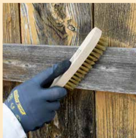
Czyszczenie powierzchni za pomocą szczotki drucianej.
