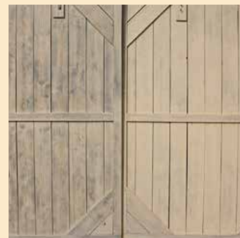
To podłoże miało tak bardzo zróżnicowaną chłonność, że nałożenie jednej warstwy nie pozwoliło uzyskać równomiernie wyglądającej powłoki. Po nałożeniu drugiej warstwy Remmers Renovier-Grund wynik był już perfekcyjny.
