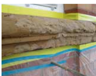
Silnie zwiertzałe gzymsy podokienne.
