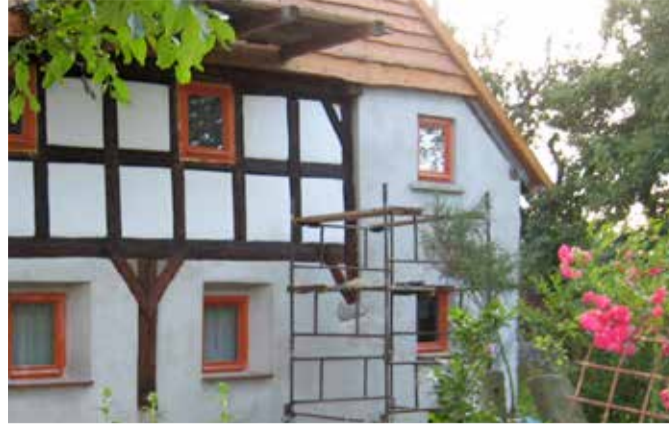
Obiekt w trakcie renowacji
