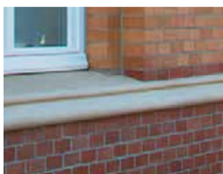
Gzyms piaskowcowy po reprofiliacji za pomocą zaprawy Remmers Restauermörtel.
