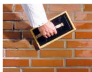
Szlamowanie spoin materiałem Funcosil
