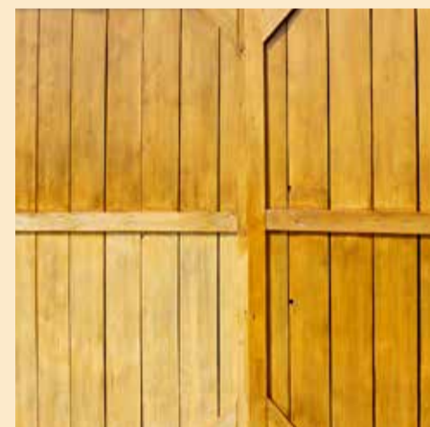
Dwukrotna aplikacja Remmers Wetterschutz-Lasur UV, aby uzyskać warstwę o grubości, która wytrzyma wieloletnie narażenie na czynniki atmosferyczne. Dzięki temu kolor wybrany z wzornika okazał się również doskonale trafiony.
