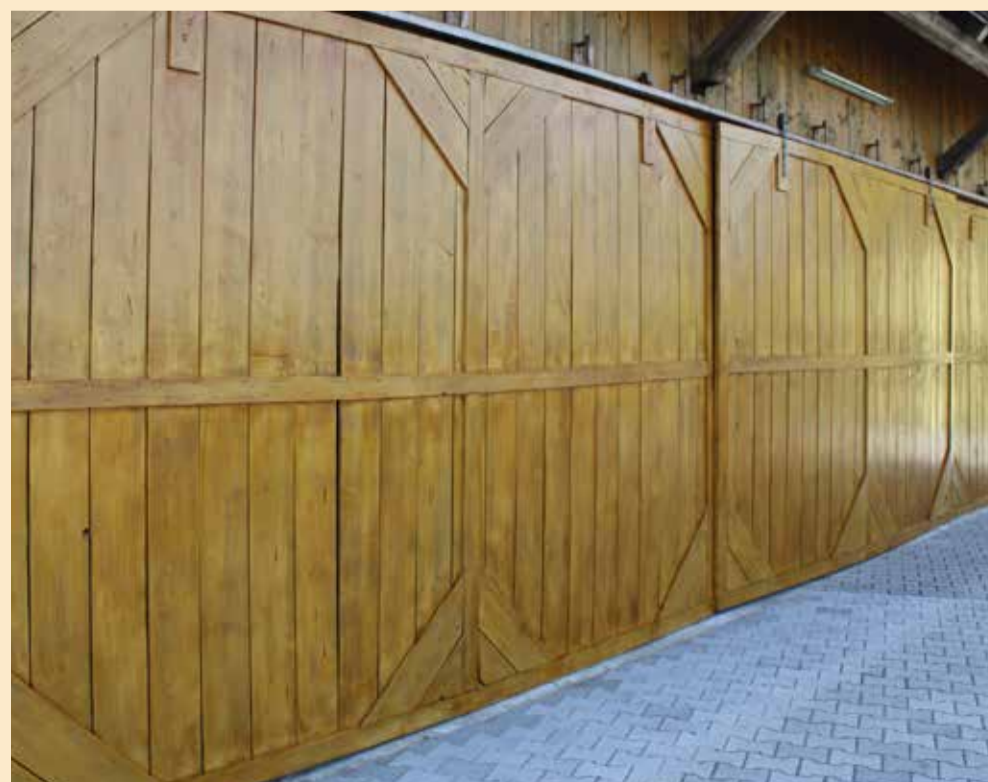
Dzięki krótkim czasom schnięcia system powłok udało się nałożyć w ciągu zaledwie jednego dnia.
