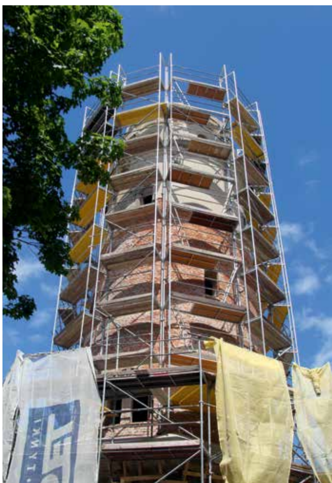
Wieża ciśnień - stan w trakcie renowacji
