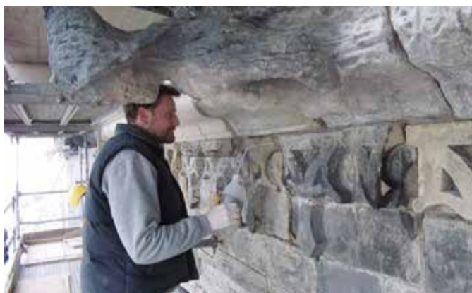
Miejscowe wzmacnianie piaszczących miejsc w ozdobnym fryzie za pomocą pipety. Nad konserwatorem - ekstremalnie zniszczony gargulec
