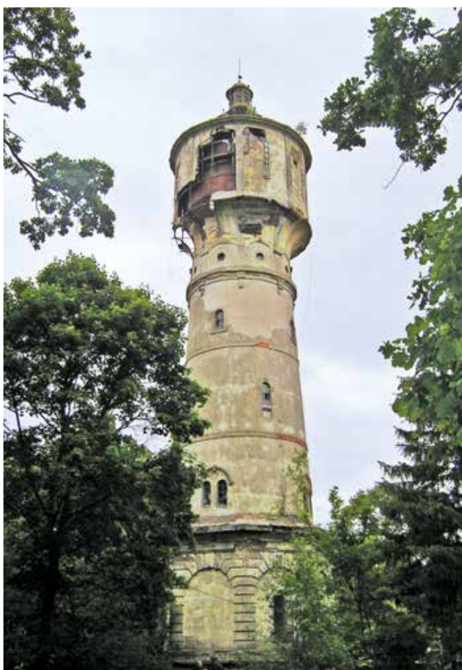
Wieża ciśnień - stan przed renowacją
