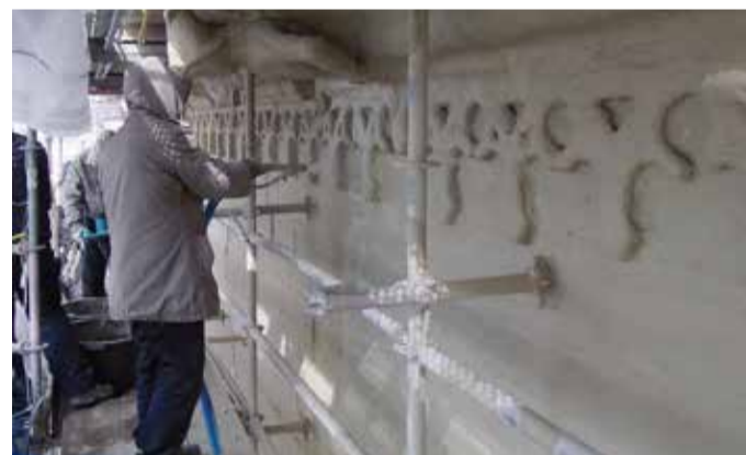
Nakładanie kompresu za pomocą pompy
