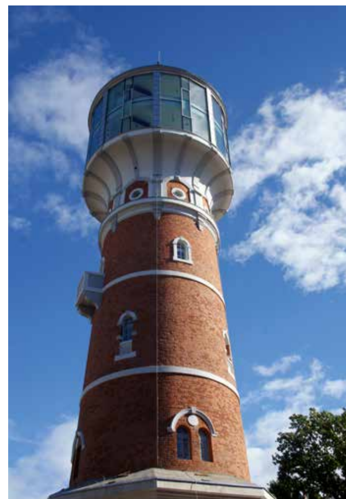
Wieża ciśnień - stan po renowacji
