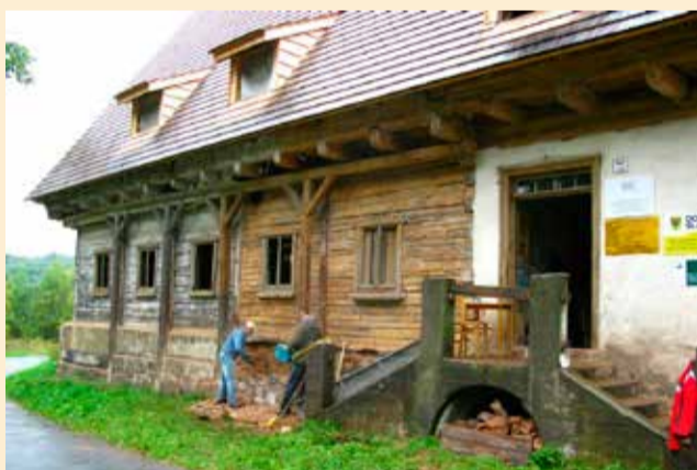
Czyszczenie drewna rozpoczęte
