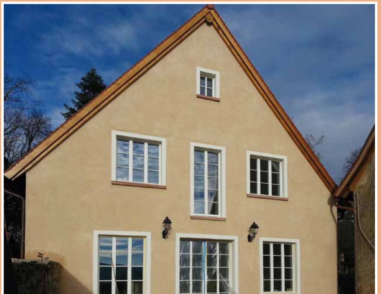
Południowa strona budynku gospodarczego w grodzie Brandenstein prezentuje elewację pokrytą tynkiem Remmers Historic Kalkspatzenmörtel. Fot: Bernhard Kretschmann
