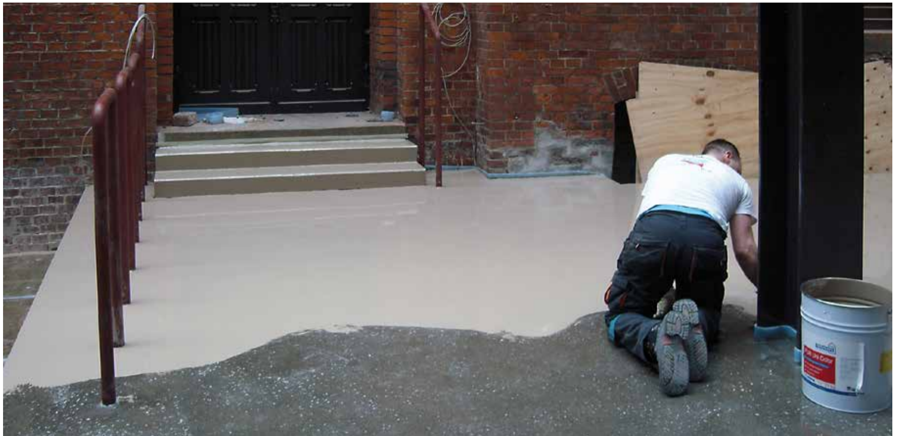
Gotową mieszankę uniwersalnej powłoki PUR Uni Color można zaraz po sporządzeniu nakładać i rozprowadzać po przygotowanej posadzce w pomieszczeniu.
