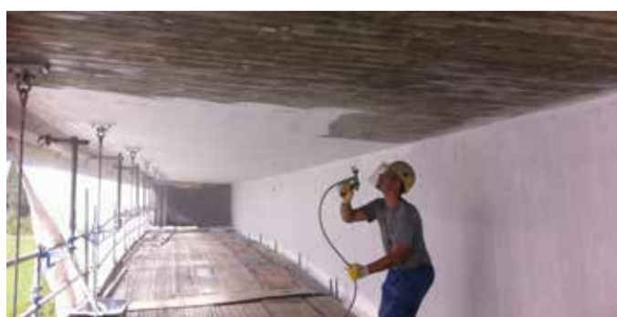
Powłoka ochronna „OS Concre-Fill” marki Remmers została najpierw nanieślona metodą natryskową, w technice airless.
