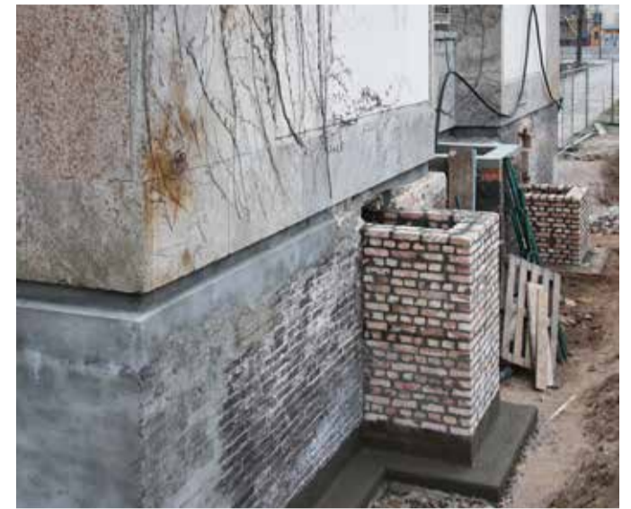
Uszczelnione ściany piwnicy
