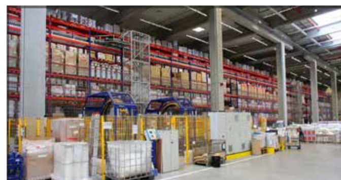
Widok części nowego Centrum Logistycznego z Magazynem Centralnym
