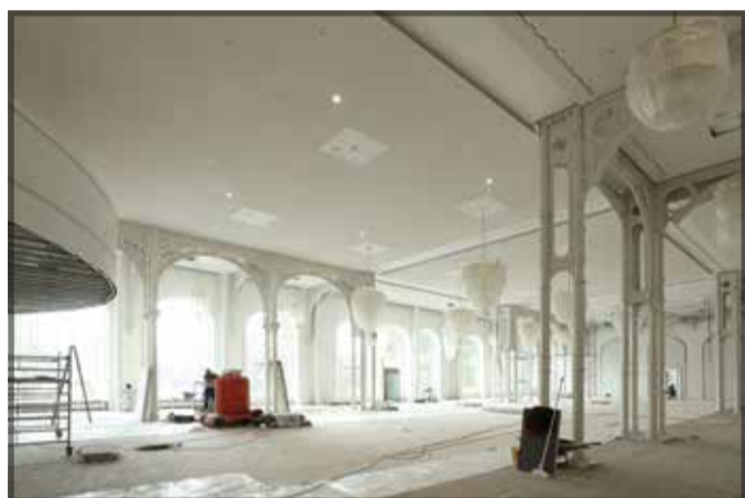
Układanie parkietu i nakładanie powłoki
