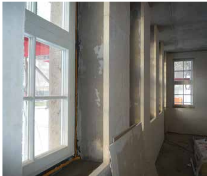
Montaż termoizolacji wewnętrznej iQ-Therm
