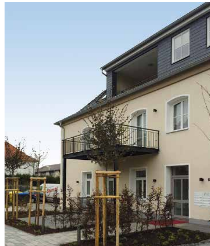
Dwukondygnacyjna nowa budowla z podziemnym garażem i ośmioma mieszkaniami.
