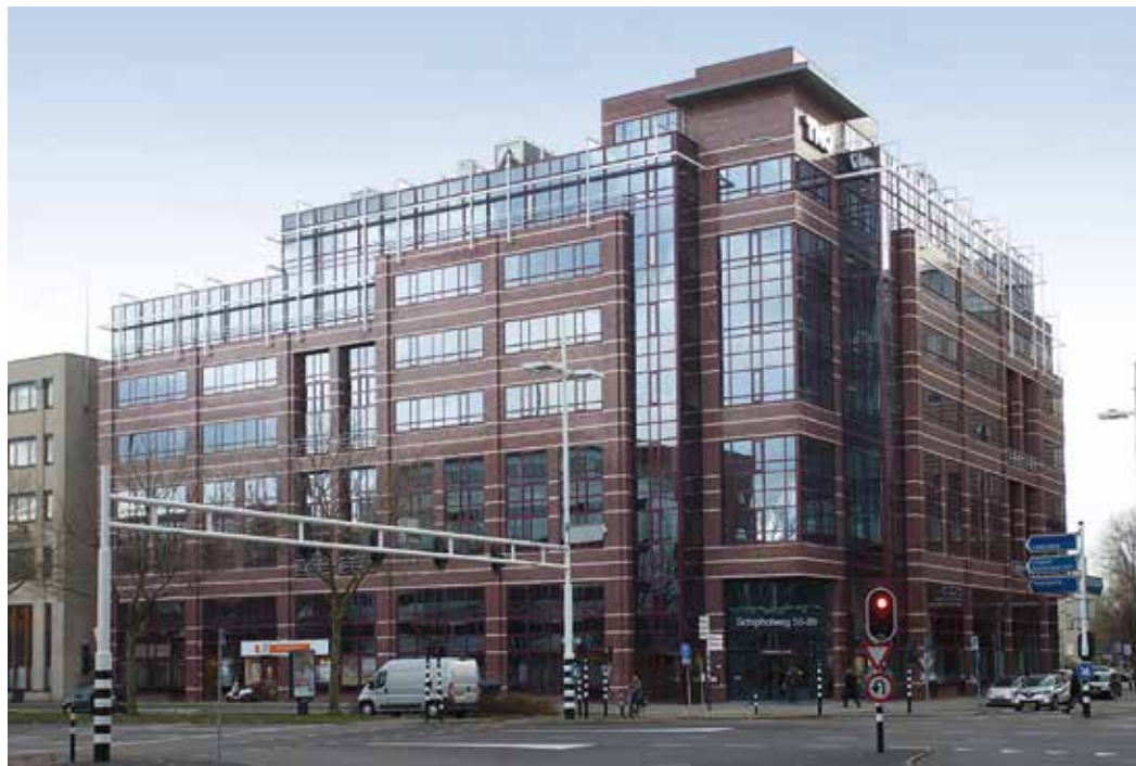
Biurowiec przy Schipholweg 55 w Leiden, Holandia
