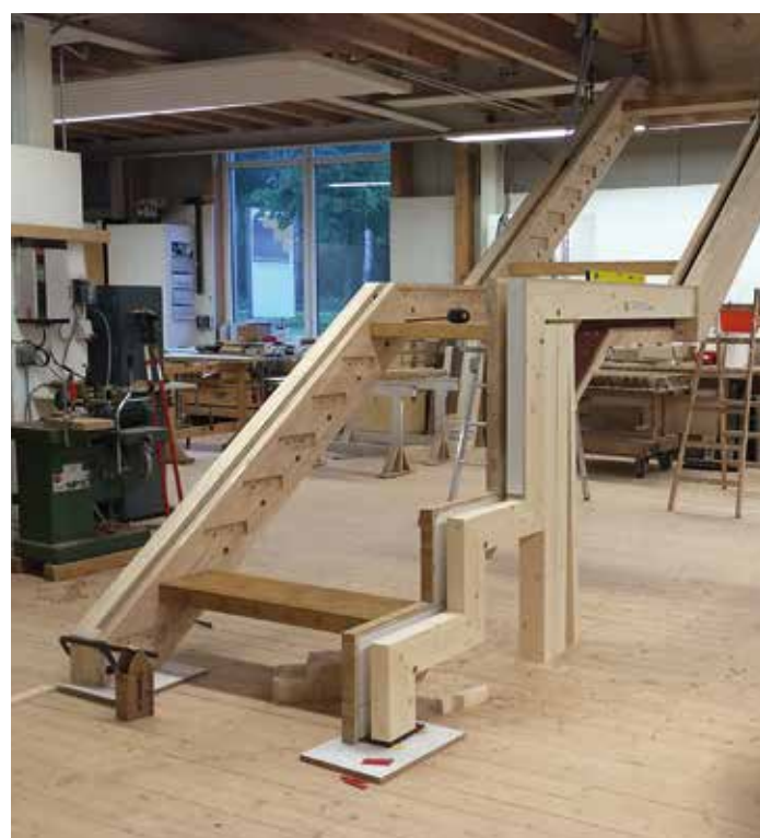
Budowa dwumetrowej szerokości schodów drewnianych z rdzeniem stalowym
