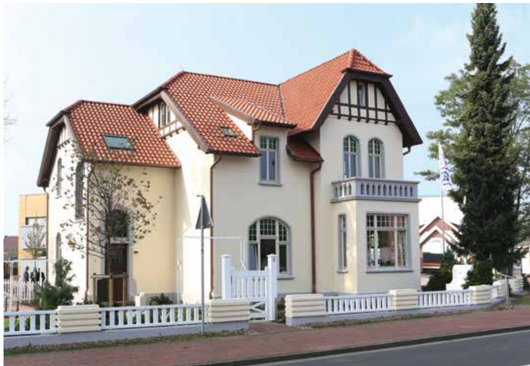
Secesyjna willa zbudowana w 1914 roku po renowacji.
