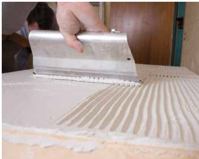
W celu zamontowania płyt termoizolacyjnych nakłada się równomiernie klej iQ-Fix na wyrównane podłoże oraz na płyty, używając pacy ząbkowanej.
