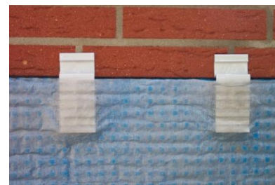
Abb. 3 Schutzbahn hinter DS Protect Clips ziehen. Vlies vor den DS Protect Clips positionieren.
