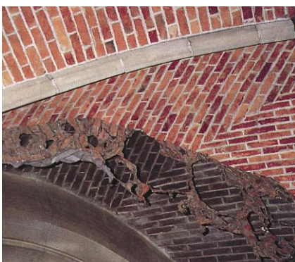
Abb. 18: Liedekerke St.Niklaas, Belgien, Reinigung des Ziegelgewölbes mit Remmers Arte Mundit®
