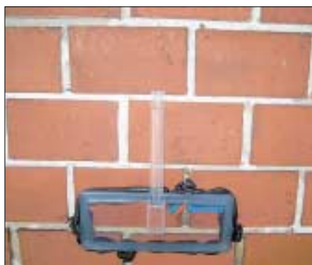
Messung des Wasseraufnahmekoeffizienten, Vorzustand
