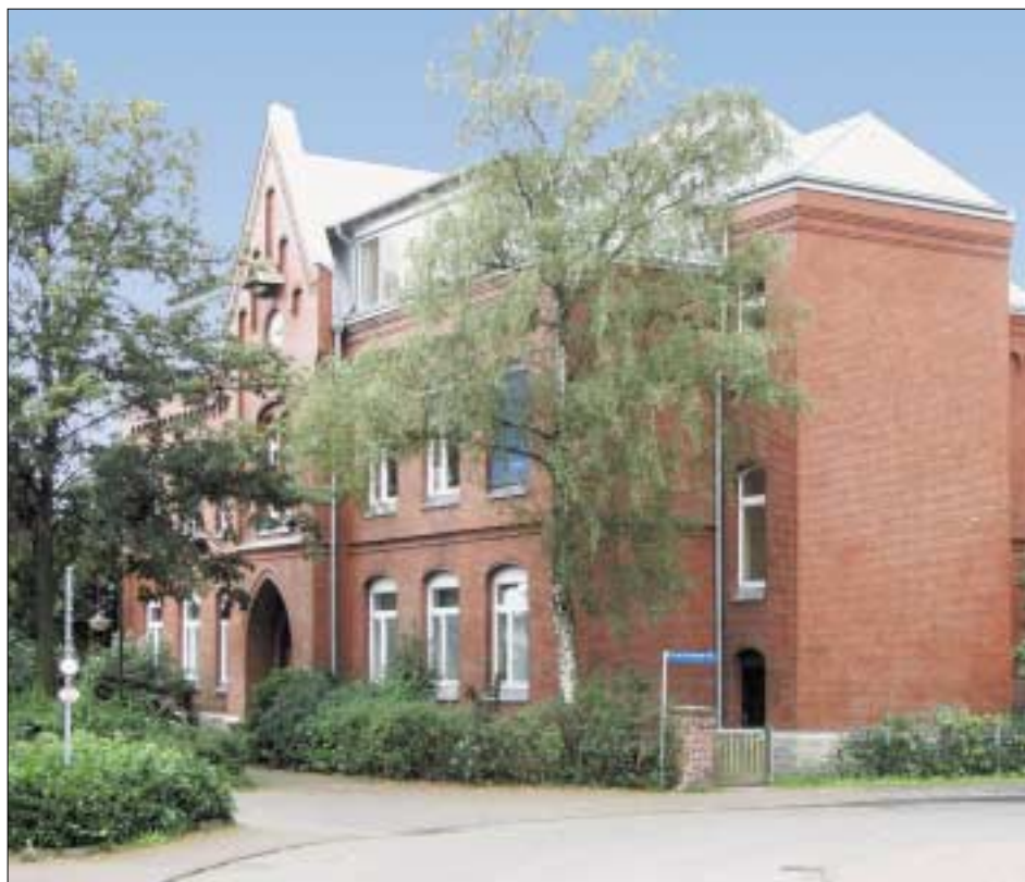
Die Wenneberschule in Rheda-Wiedenbrück: Instandsetzung mit der Funcosil Ziegelschlämmverfugung im Rahmen der Remmers System-Garantie RSG: Gütezeichen für ein bewährtes Produktsystem mit gewissenhafter handwerklicher Ausführung und 10 Jahre Garantie für den Instandsetzungs- und Abdichtungserfolg!
