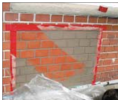
Anlage einer Probefläche
