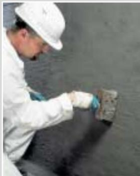
Erste und zweite Abdichtungsschicht im Schlämmverfahren bis max. 5 mm Schichtstärke mit **Aida® SULFATEXSCHLÄMME - schnell** - evtl. 3. Abdichtungsschicht bei Druckwasserbelastung. Alternativ im Spachtelverfahren noch schneller durch nur einen Auftrag. Schnelle Reaktion der gesamten Abdichtungsschicht.
