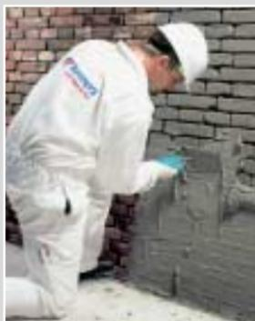
Egalisierung und Vorabdichtung des Untergrundes und Herstellung der Hohlkehle mit **Aida® DICHTSPACHTEL**. Sehr gute Standfestigkeit bei Schichtdicken von 0 - 50 mm in einem Arbeitsgang. Trotz Schnellabbindung lange Verarbeitbarkeit, angenehm geschmeidige Konsistenz. Extrem schnell mit der Abdichtung überarbeitbar.
