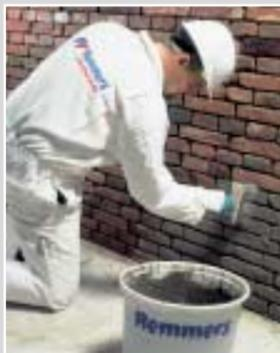
Haftbrücke und erste Abdichtung in einem Arbeitsgang mit **Aida® SULFATEXSCHLÄMME - schnell** - mit sehr guter Haftung zum Untergrund.
