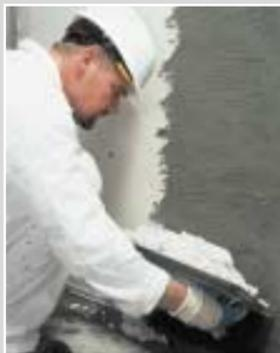
Sanierputzauftrag mit **SANIERPUTZ - Altweiß** - Auftrag im Spachtel- oder Anwerfverfahren, ohne vorherigen Spritzbewurf. Sehr gute Verarbeitungseigenschaften per Hand oder Maschine. Optimaler Strukturaufbau und Faserzusatz zur rissfreien Aushärtung. Anwendbar im Innen- und Außenbereich, hohe Resistenz- und Salzspeicherfähigkeit.
