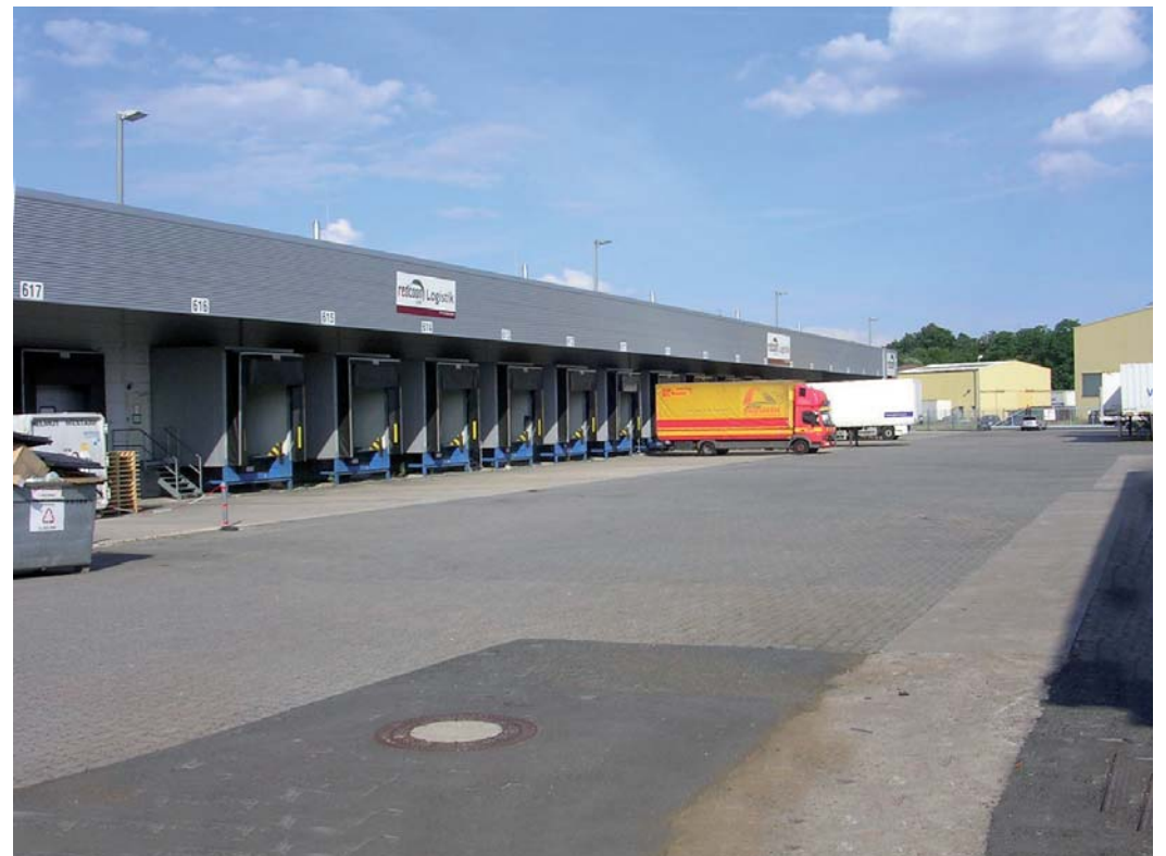
Außenaufnahme der Logistikhalle mit den Verladerampen aus dem Jahr 2010
