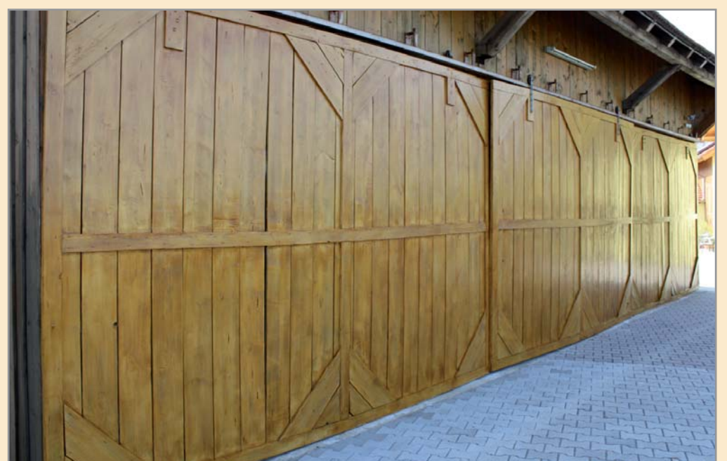
Komplette Anstrichfolge der Flächen an nur einem Tag, da nur kurze Trocknungszeiten erforderlich waren.
