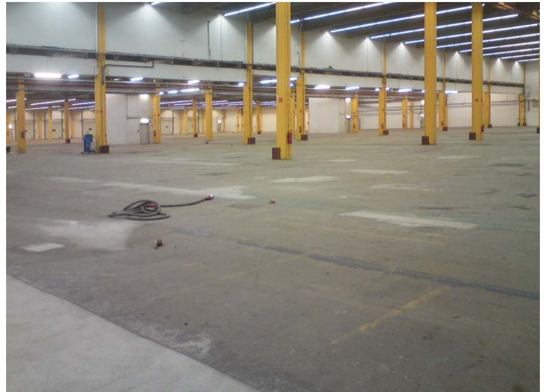
Fehlstellen und Unebenheiten wurden überarbeitet – jetzt kann beschichtet werden.
