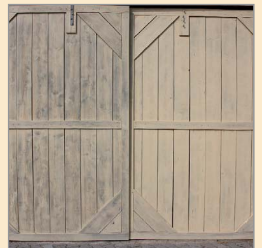
Auf diesem wolkigen, extrem unterschiedlich saugenden Untergrund war mit einem Auftrag kein gleichmäßiges Anstrichbild zu erreichen. Nach zweimaligem Auftrag von Remmers Renovier-Grund war das Ergebnis perfekt.
