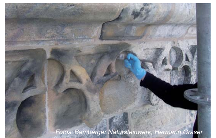
Detailarbeit beim Schlämmen, Stein für Stein.
