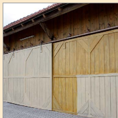
Wetterschutz-Lasur UV im Farbton "eiche hell" zeigte sich ideal geeignet: der Farbton wirkt optisch wie auf rohem Nadelholz appliziert.
