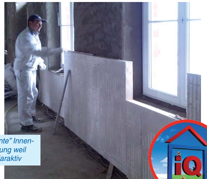
Montage der Innendämmung iQ-Therm 80.
