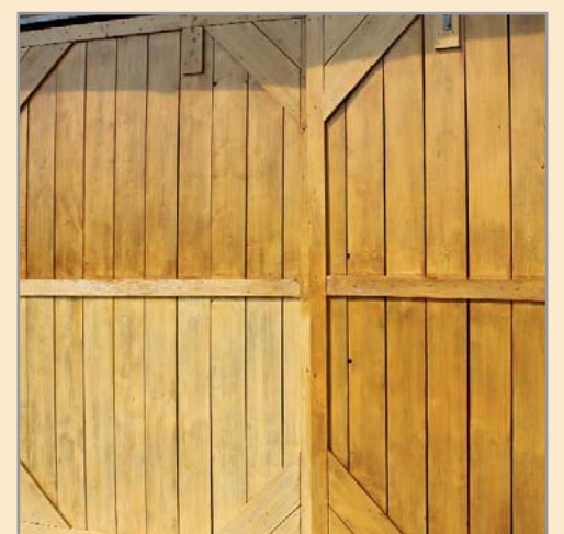
Zweimaliger Anstrich mit Remmers Wetterschutz-Lasur UV, um eine Schichtstärke zu gewährleisten, die über Jahre hinweg der Bewitterung standhält. Damit wurde auch der ausgewählte Farbton lt. Farbtonkollektion genau getroffen.
