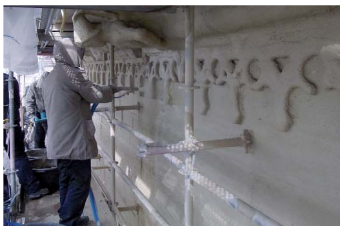
Auftrag der Kompressen mittels Pumpe
