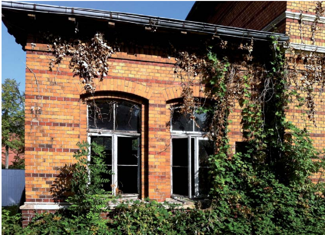
„Alter Bahnhof“ Warendorf - Vorzustand.
