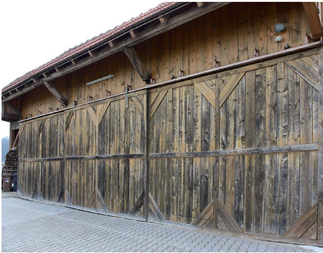
Vorzustand des ehemals landwirtschaftlich genutzten Gebäudes.
