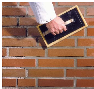
Funcosil Schlämmverfugung.
