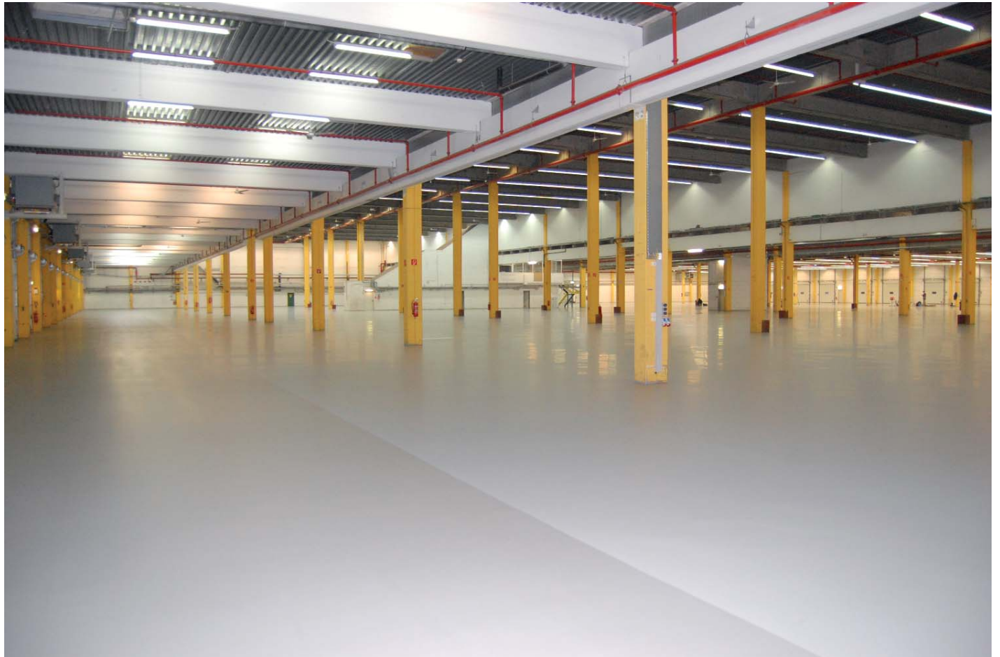
Logistikhalle nach der Neubeschichtung mit dem PUR Inducolor-System von Remmers
