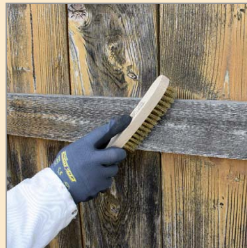
Säubern der Oberfläche mit Drahtbürste.
