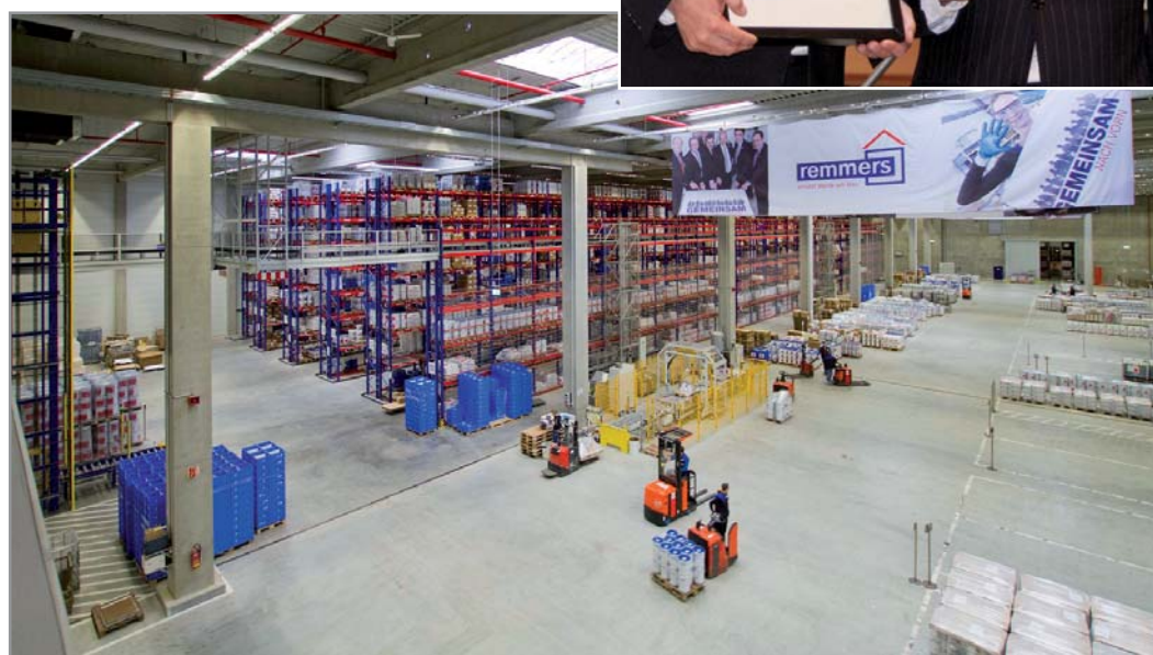
Der Neubau des 17.200 Quadratmeter großen Europäischen Logistikzentrums am Firmensitz Lönningen ermöglichte die Optimierung aller Prozesse in der Transport-, Lager- und Produktionslogistik für die schnelle und flexible Abwicklung von Kundenaufträgen.
