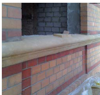
Mit Remmers Restauermörtel reprofiliertes Sandsteingesims.
