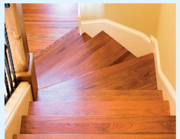
Der Aqua TL-412 ist die nächste Generation der einkomponentigen Treppenlacke! Seine hochwertigen Acrylat- und Polyurethan-Bindemittel benötigen keine Härterkomponente und sorgen dennoch für eine lange Lebensdauer der Oberflächen von Handlauf und Stufen. Die spezielle Rezeptur bewirkt eine hohe Abrieb- und Kratzbeständigkeit dieser hoch beanspruchten Bauteile. Auch ein weiteres Detail gefällt: die nochmals verbesserte Widerstandsfähigkeit gegenüber Handcreme und Putzmittel.
