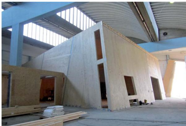
Bau der Innenwände mit 20 Grad Neigung.
