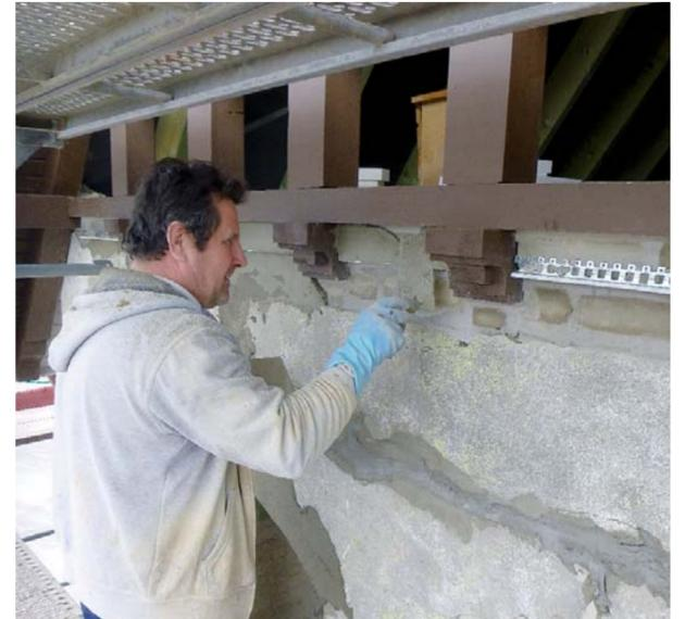
Neue Nutzung nach energetischer Sanierung mit dem Innendämm-System iQ-Therm
