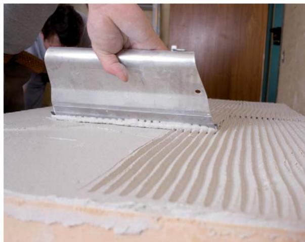
Für die Montage wird iQ-Fix auf den ebenen Untergrund und die Platte mit einer Zahnkelle gleichmäßig auftragen.
