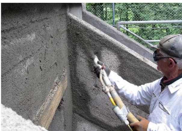
Auftrag Betonersatz / Egalisierung mit Betofix R4 SR im Spritzverfahren.
