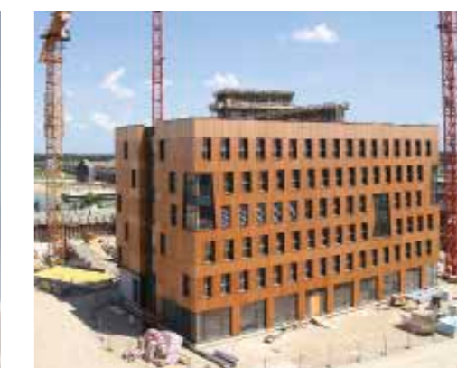
Budowa wieżowca HoHo w Wiedniu w styczniu 2018
