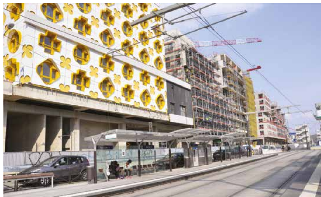
Entrepôt Macdonald w Paryżu (Francja).
