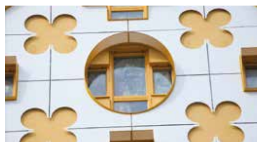
Entrepôt Macdonald w Paryżu (Francja).
