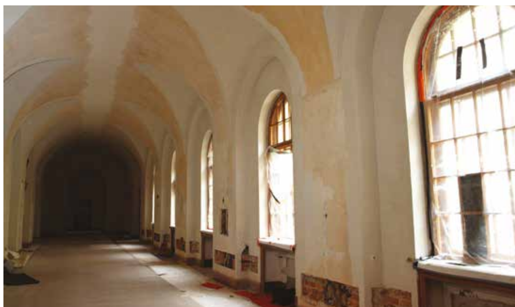
Okna podczas prac renowacyjnych.
