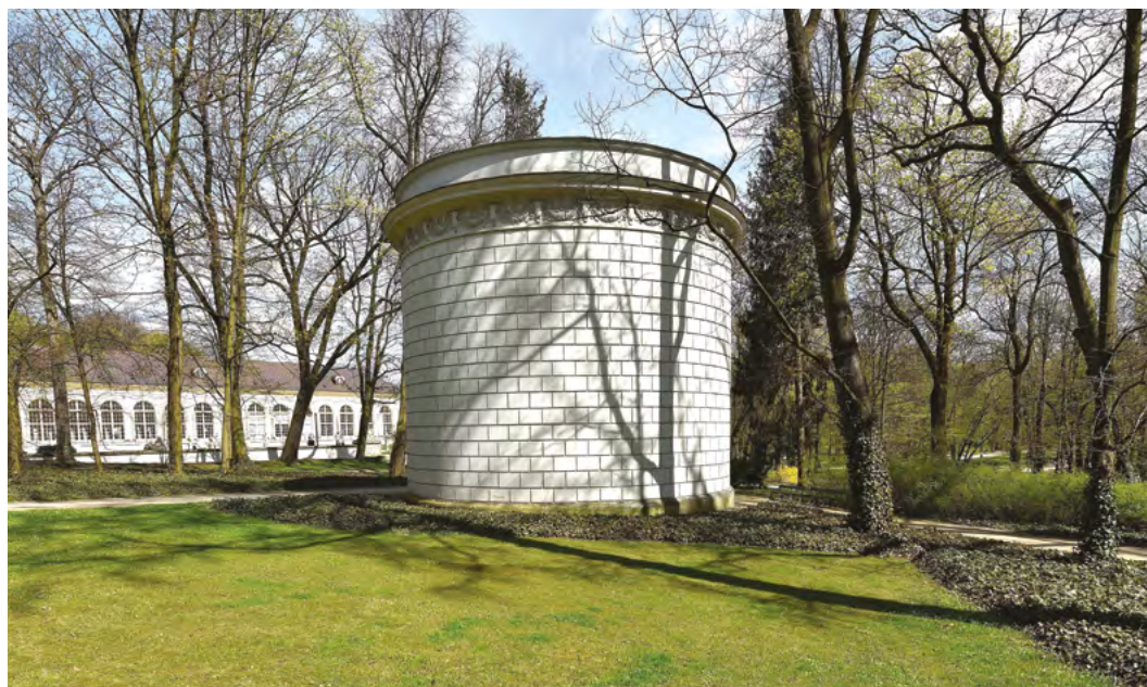
Wodozbiór w Łazienkach Królewskich
