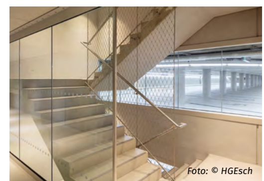
Dziewięć klatek schodowych z 1278 pojedynczymi stopniami oraz przynależne do nich podesty i poziomy pośrednie zostały wykończone powłoką z żywicy syntetycznej.
