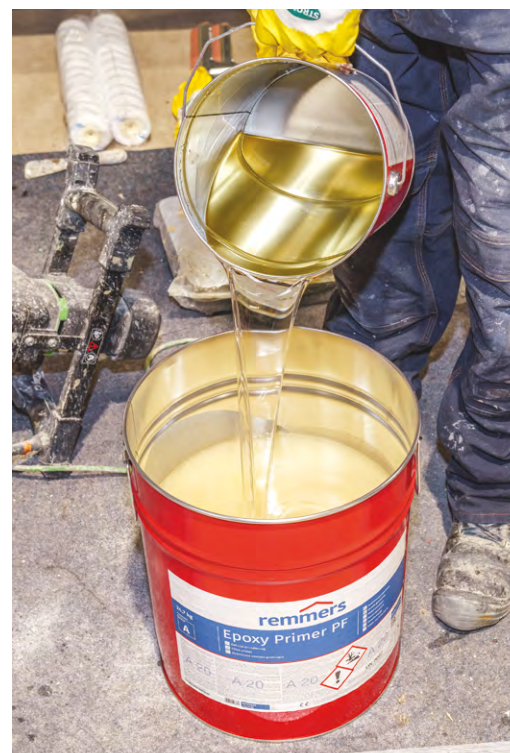
Epoxy Primer PF stanowi podstawę dla nowej bazy do czyszczenia butelek
