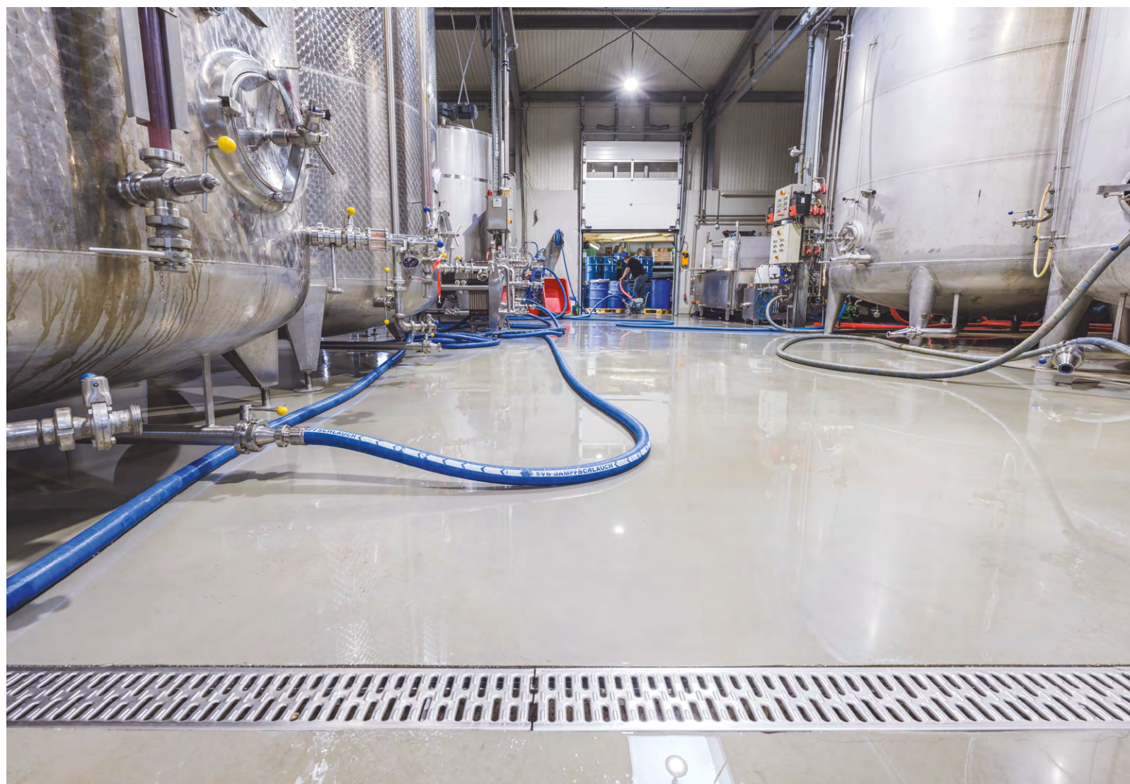
Dzięki nowej powłoce z betonu poliuretanowego podłoga zakładu produkcyjnego jest gotowa na obciążenia powstające w wyniku codziennej pracy zakładu
