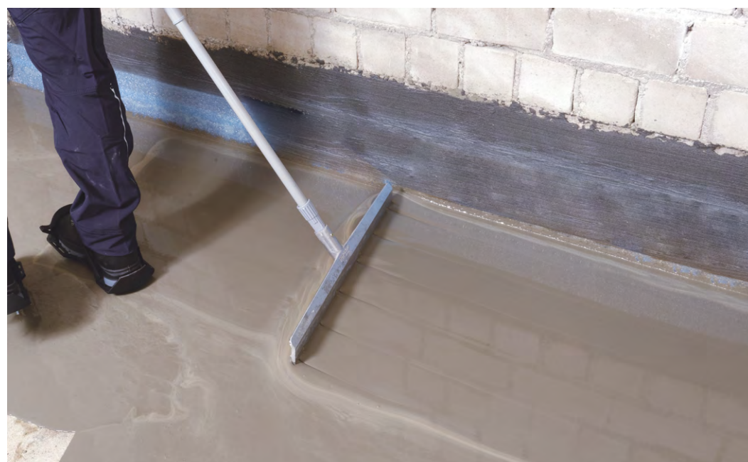
W celu uzyskania właściwości uszczelniających wystarczy warstwa o grubości 10 mm
