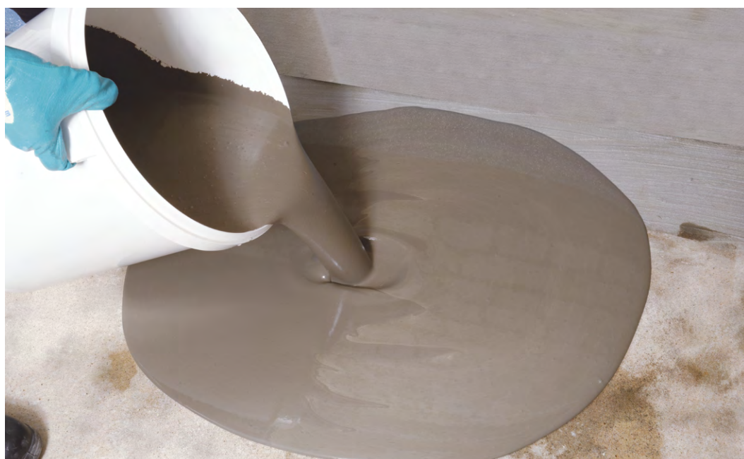
Remmers WP Flow stosuje się jak standardową wylewkę samopoziomującą
