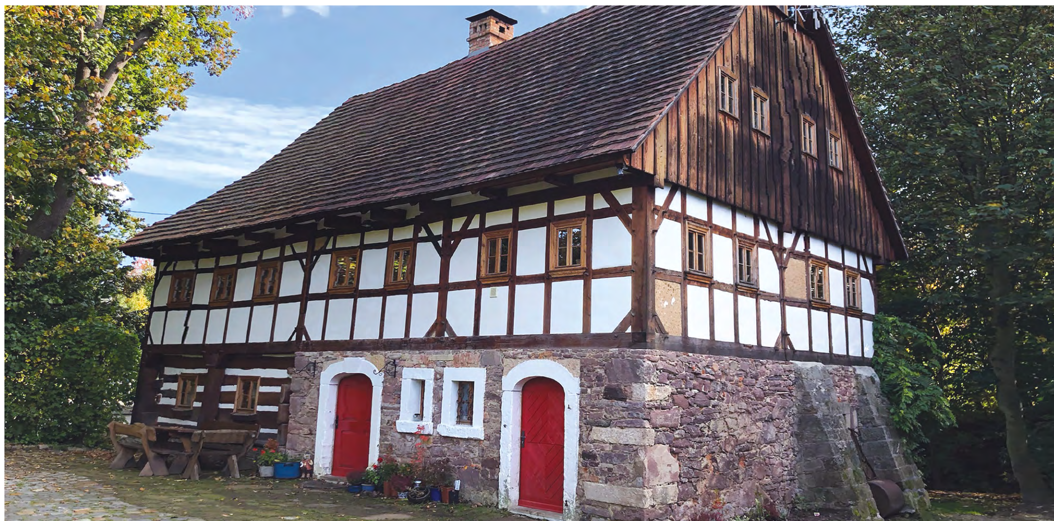
Dom przystupowy w Proboszczowie
