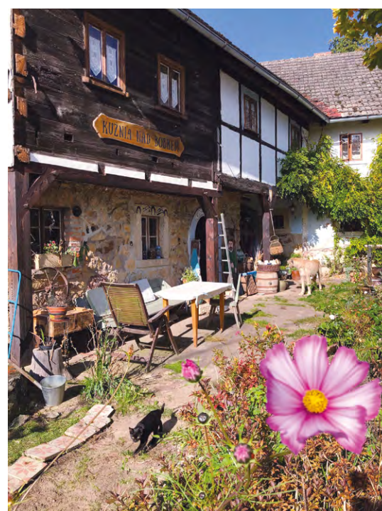
Kuźnia nad Bobrem w Przeździeczie
