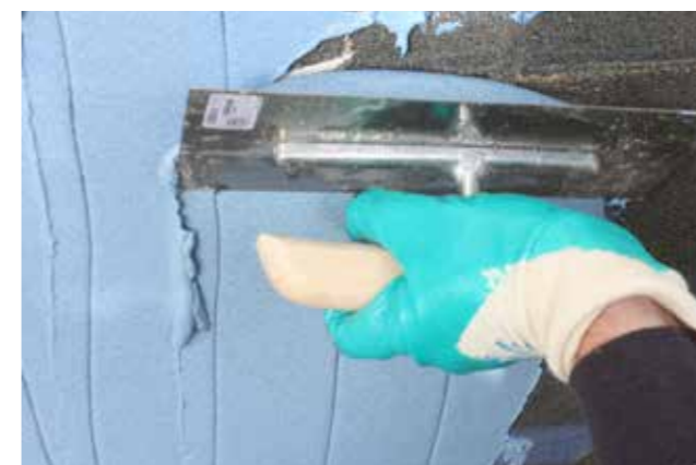
MB 1K rapid: applicazione con cazzuola a spessore
