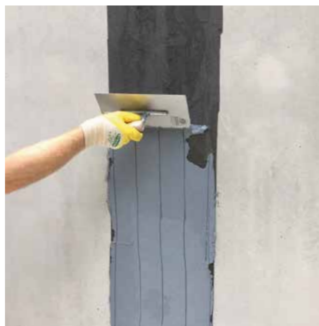
Striscia di impermeabilizzazione dei giunti con MB TX 2K per scantinati in calcestruzzo impermeabile
