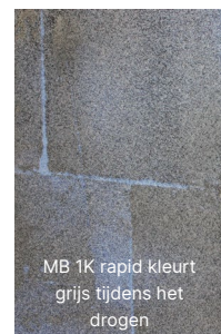
Oppervlak met pas aangebrachte slurry
